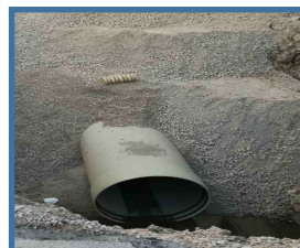
Aperçu d'une canalisation en PRV sur un chantier à MOREZ
