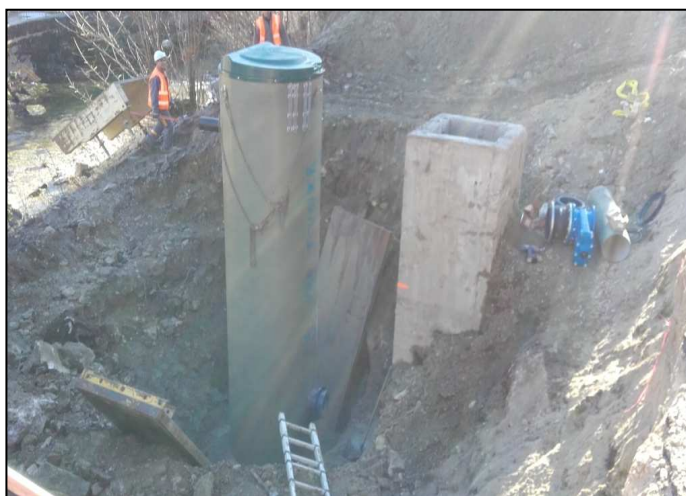
Aperçu de la pose d'un poste de relevage à une profondeur importante (3 m contre 4.6 m pour le présent dossier)
