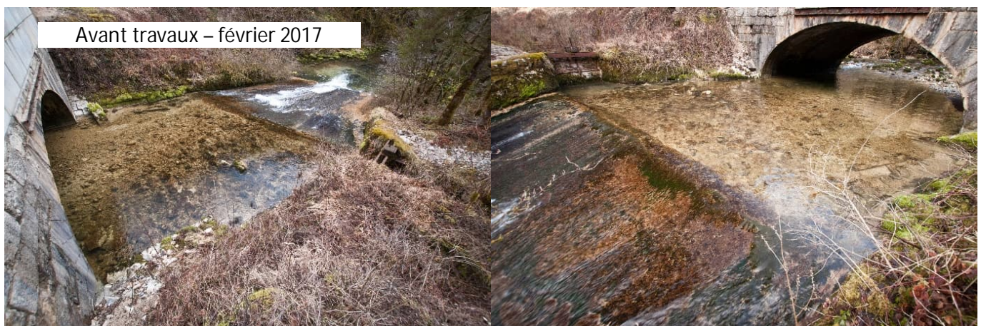
Figure 2 : Seuil du Grosdar 3 : avant travaux d'effacement.
