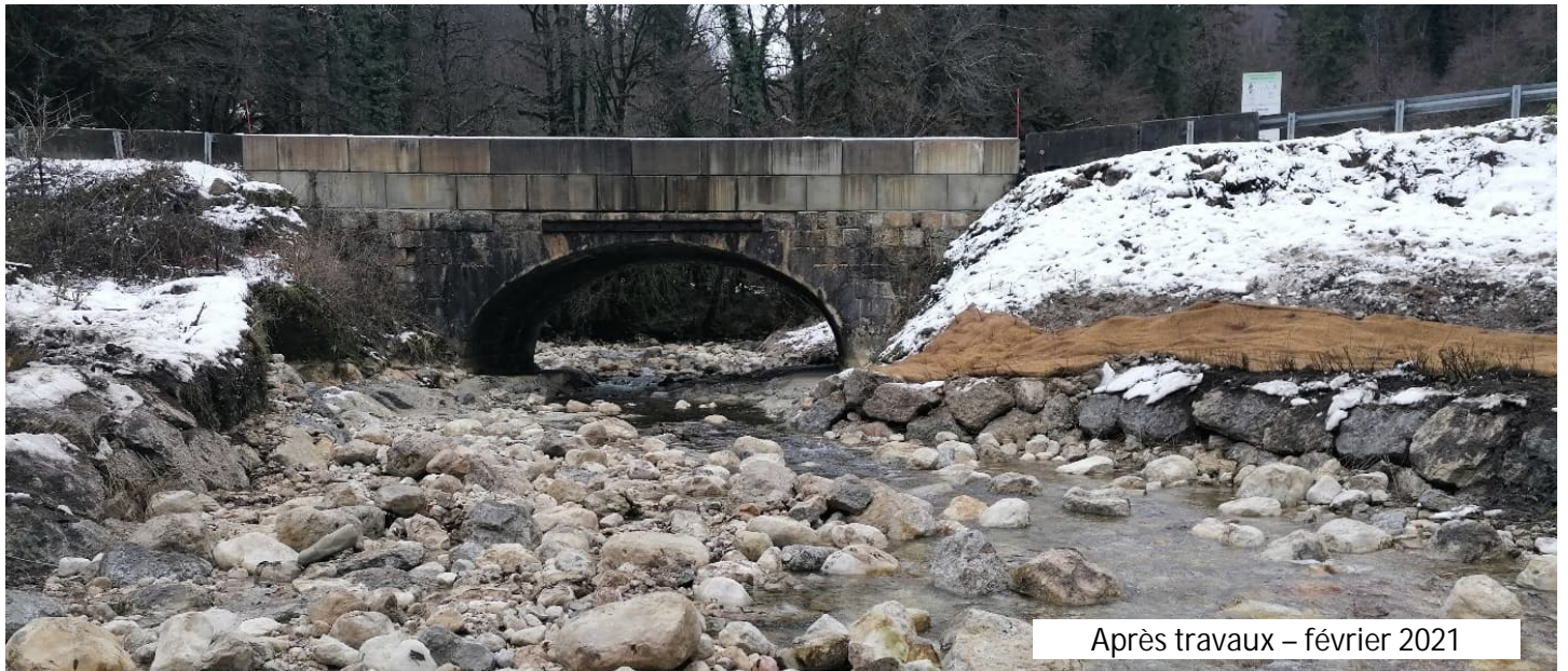
Figure 2 : Seuil du Grosdar 3 : après travaux d'effacement.
