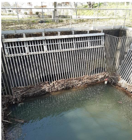
Figure 4 : Ouvrage de répartition – vue vers l'aval
