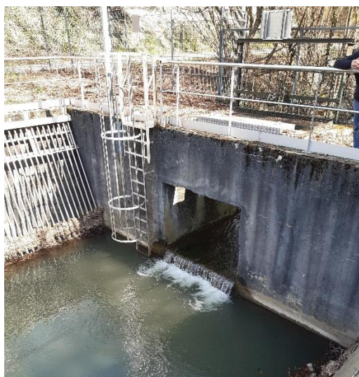
Figure 5 : Ouvrage de répartition – vue vers l'amont
