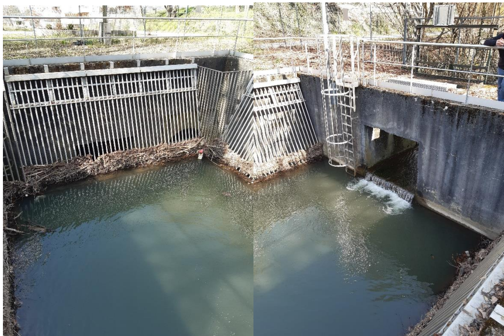
Figure 2 : Ouvrage de répartition - Figure 3 : raccordement de l'EP sur l'UN
