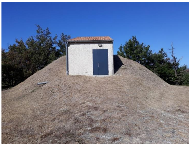
Figure 12 : Réservoir Les Voltes - vue extérieure
