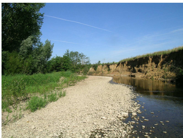
Photographie 3 : Encoche d'érosion sur le tronçon 3 de la Chalaronne.
