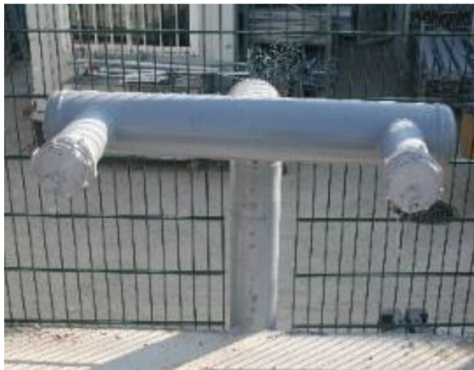
Exemple de colonne d'aspiration
