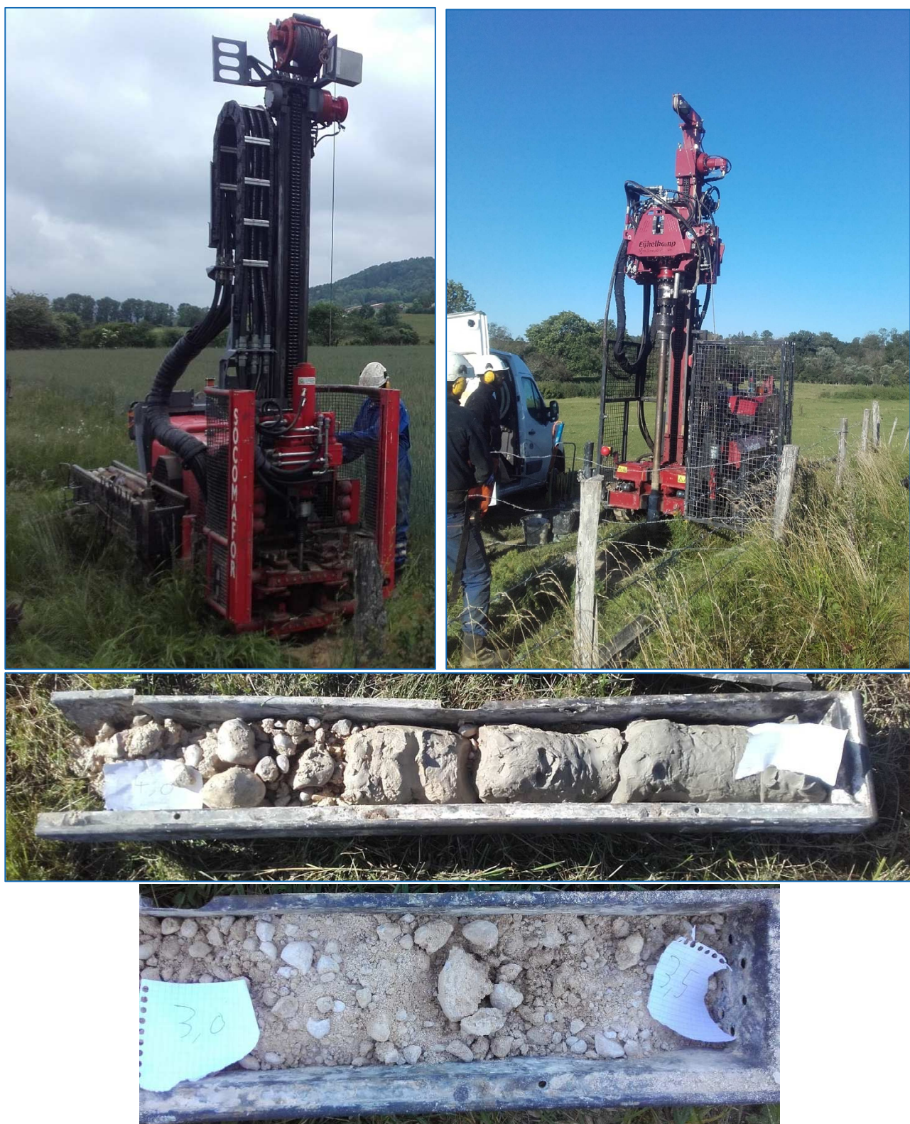
Figure 13 : Illustration des travaux : marteau fond de trou à gauche, Sonic à droite, détail (au centre) de l'interface alluvions (sables, graviers et galets) et argiles glacio-lacustres identifié sur PzA. En bas : photo des moraines argilo-graveleuses sèches (sur PzC).
