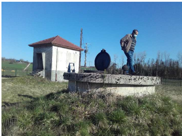
Puits de Blye et sa station de pompage
