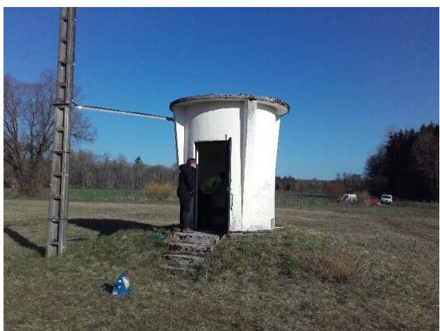
Puits Nord (ou Puits 1) du SIE Vouglans
