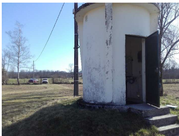
Puits Sud (ou Puits 3) du SIE Vouglans
