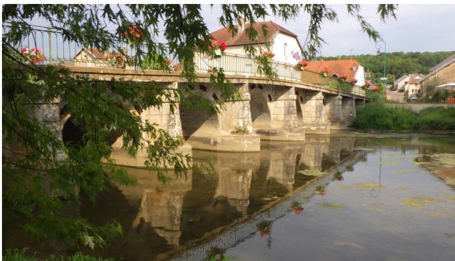
Fig. 9. Vue amont du pont (OH2)
