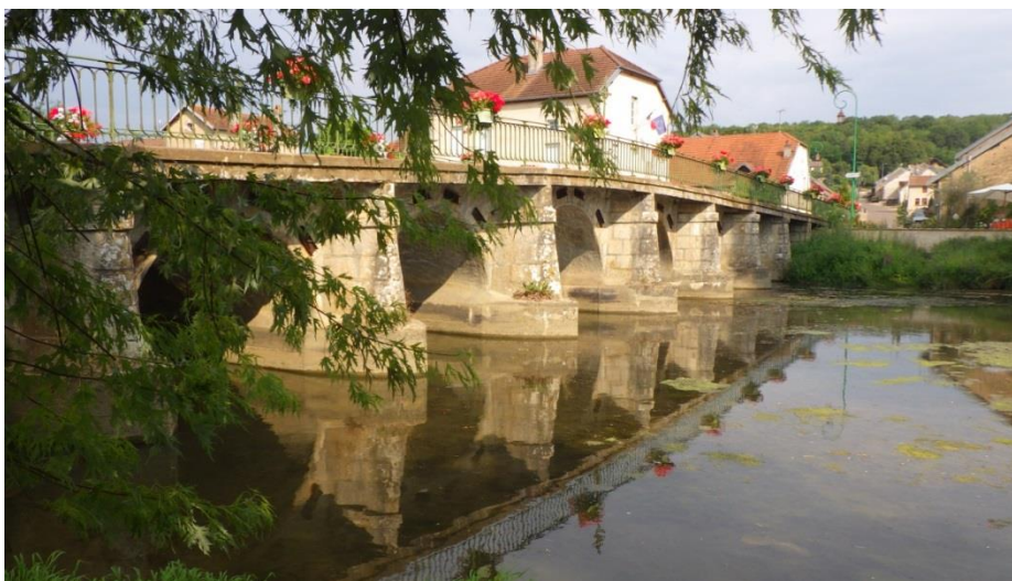
Fig. 9. Vue amont du pont (OH2)
