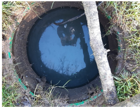
Figure 21 : Mise en charge M6
