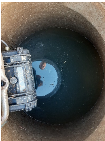
Figure 32 : Mise en charge M10
