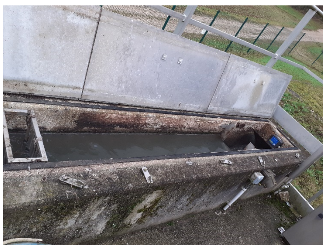
Figure 33 : Canal d'entrée et canal de sortie STEU
