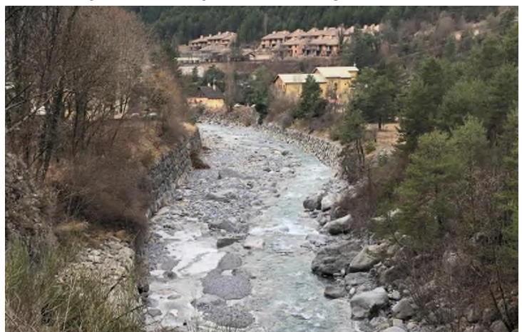
Illustration du caractère chenalisé du fleuve Var au droit de la traversée de la commune de Guillaume.
