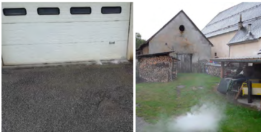
Figure 75 - Grilles avaloir connectées au réseau EU en haut de l'Impasse Sérivière
