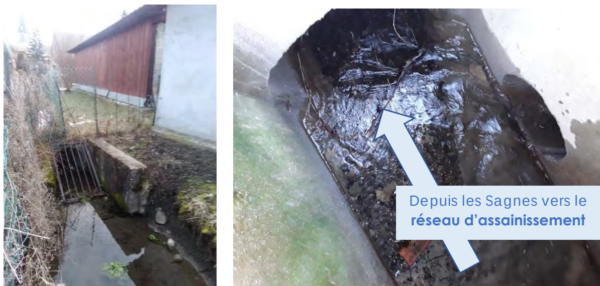
Figure 34 : Photographies du drainage des "Sagnes" dans le réseau du Chef-Lieu Ouest (RV n°21)
