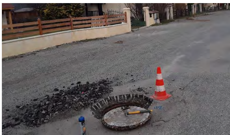
Figure 94 - Photographie d'un tampon sous chaussée
