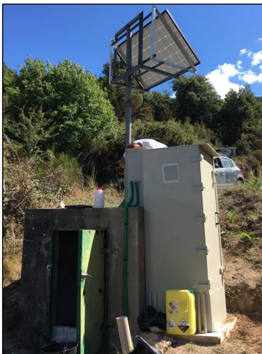
Figure 11 : Vue du répartiteur de Casaracca et de la chloration automatique
