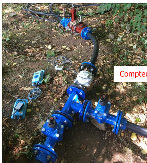
Figure 21 : Vue des travaux de déconnexion du réservoir de Meulien et du nouveau compteur
