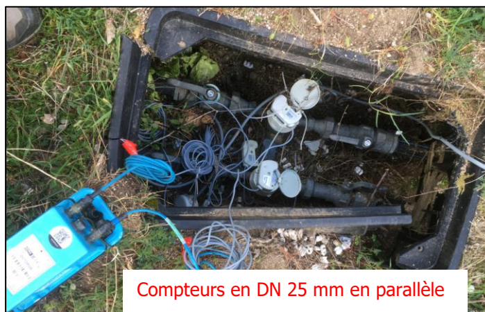
Figure 20 : Vues des compteurs équipés au niveau du réservoir de Casaracca
