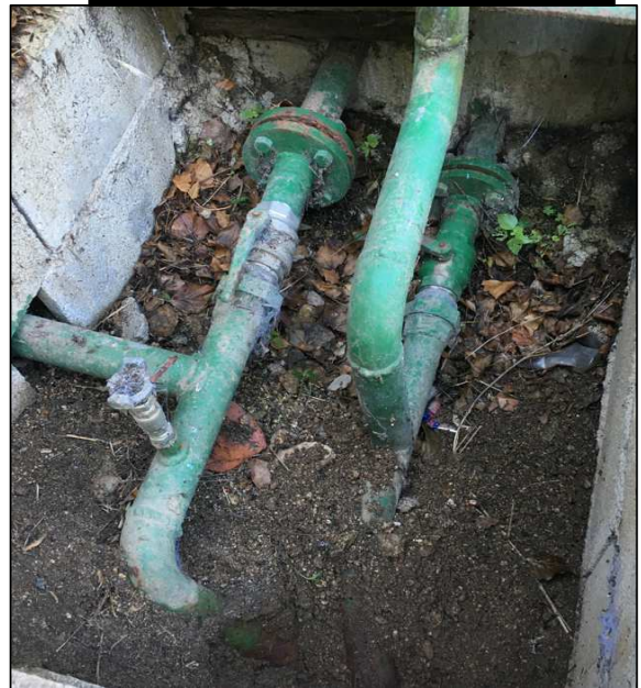
Chambre de vannes aval
