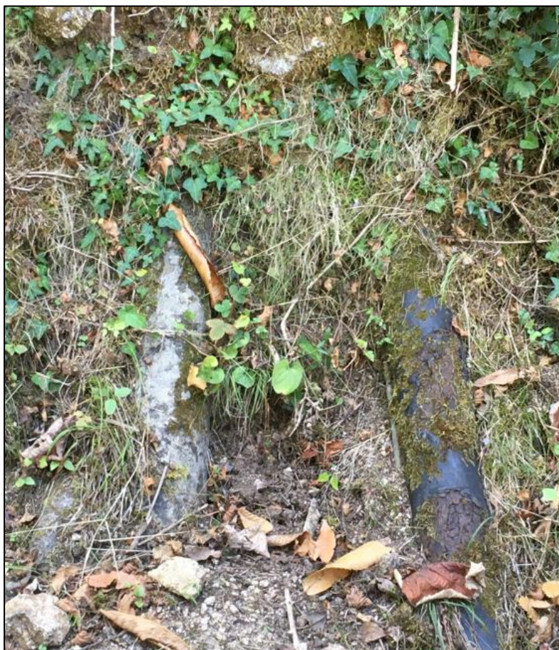
Figure 17 : Vue des réseaux en amiante ciment et acier entre Meulien et Casaracca
