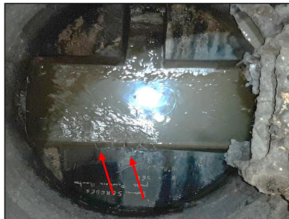
Illustration n°3 : Infiltrations sur RV Rte de Carpentras (à gauche) et RV Allée Jules Ladoumègue (à droite)
