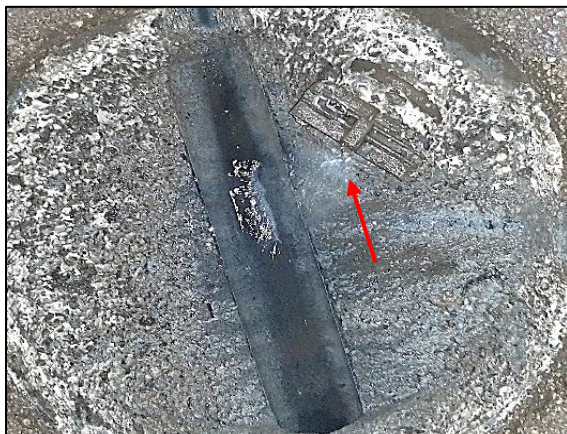
Illustration n°3 : Infiltrations sur RV Rte de Carpentras (à gauche) et RV Allée Jules Ladoumègue (à droite)
