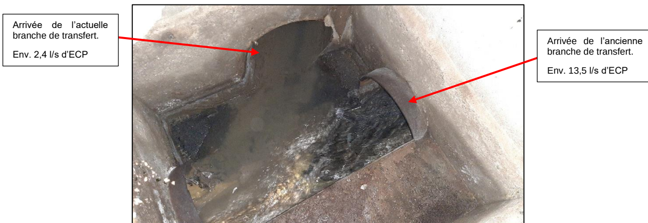
Illustration n°4 : Regard de jonction des deux branches du réseau
