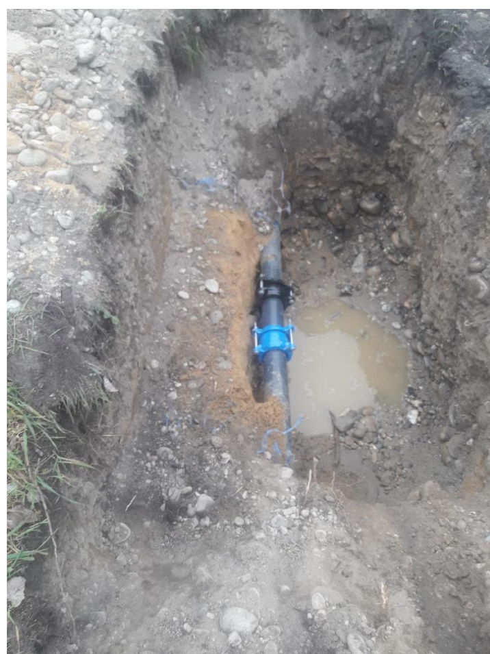
Bonne état général de la canalisation de refoulement
