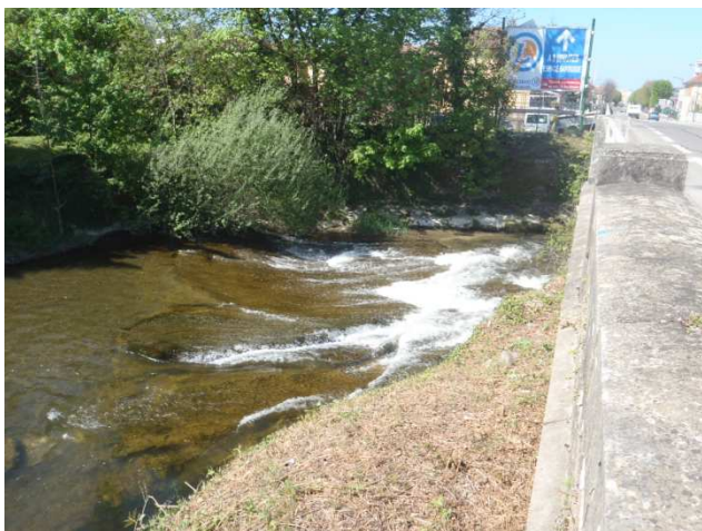
Rampe en béton en amont du pont de Ruy
