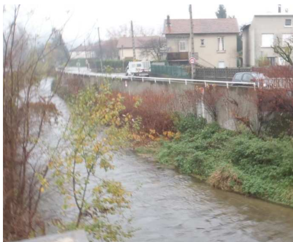
Mur de soutènement en amont immédiat du pont de la Rivoire
