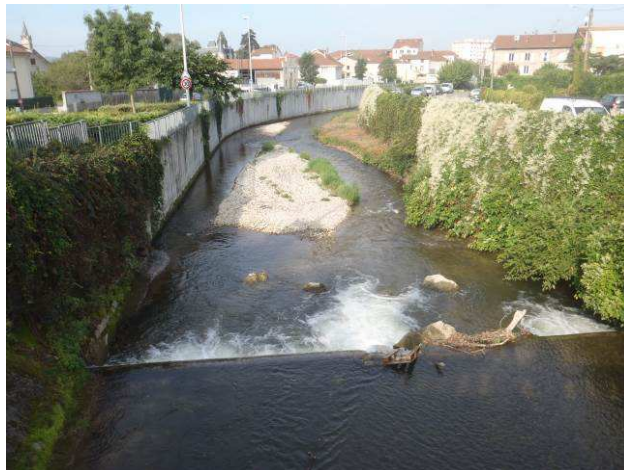
Pont de Ruy – Vue vers l'aval
