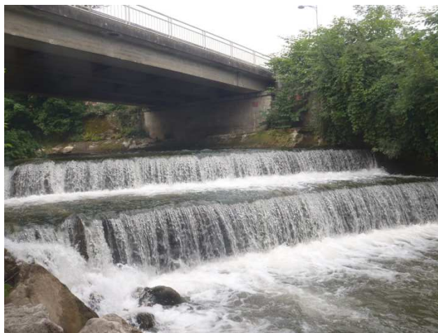
Chutes successives en aval du pont de Ruy
