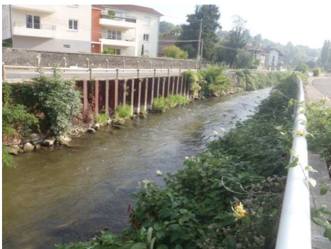
Palplanches en amont immédiat du pont de la Rivoire
