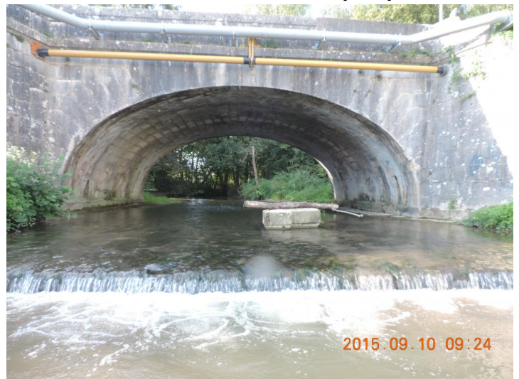
Seuil Aval + Élément de parapet
