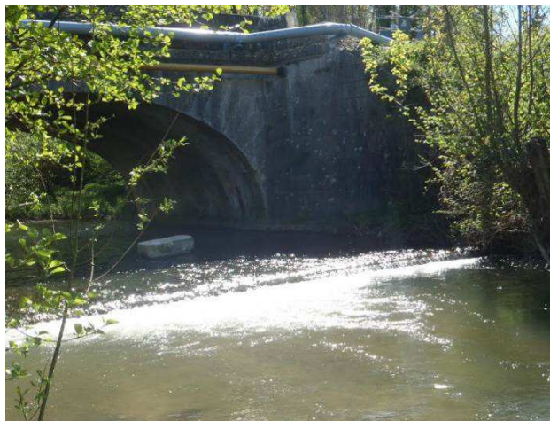
Seuil du pont du Gaz vu de l'aval
