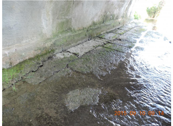
Radier en pierres maçonnées
