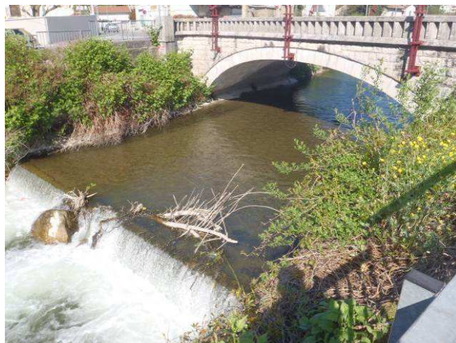
Pont de la Rivoire - Radier avec 1 chute en aval
