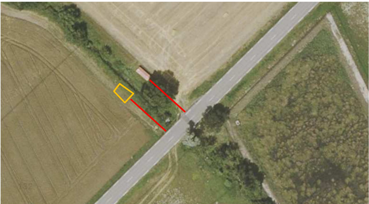
Figure 22 : Accès de chantier et stockage temporaire
