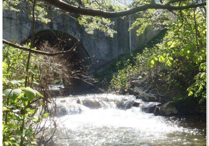
Pont du Curtet – Seuil en enrochements en aval
