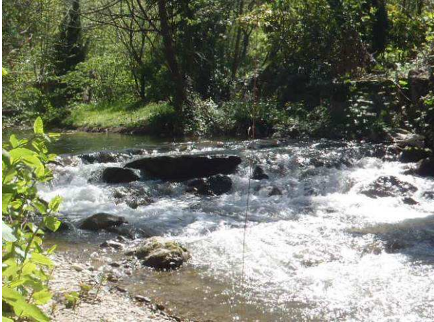
Pont du Curtet – Rampe en enrochements en amont
