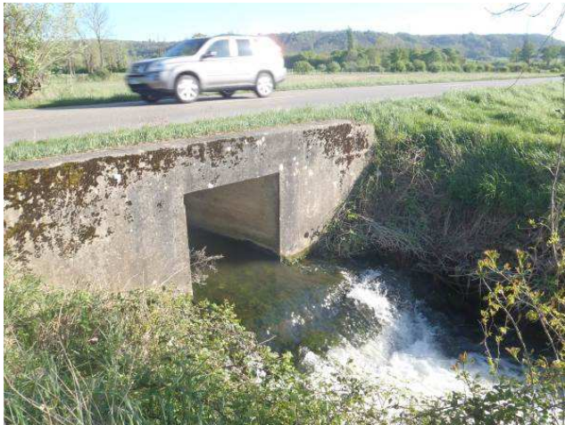
Pont du ruisseau du Ver – Radier béton avec la chute en aval
