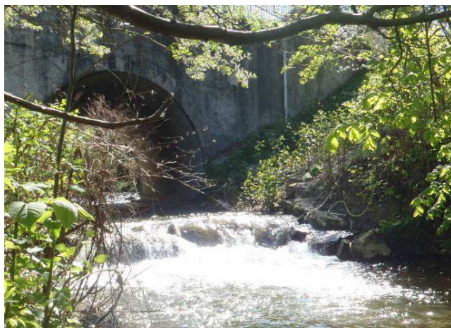
Pont du Curtet – Vue vers l'amont
