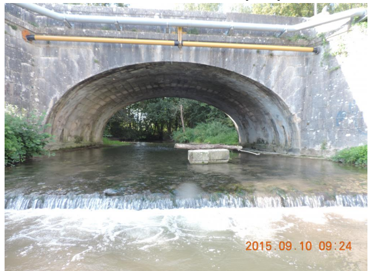
Seuil Aval + Élément de parapet
