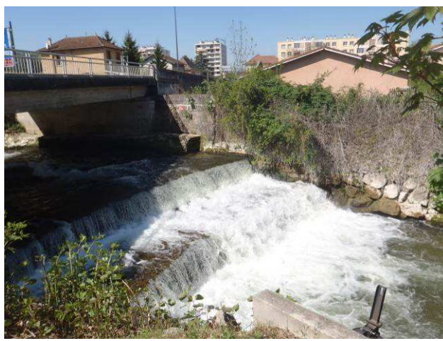
Pont de Ruy – Radier béton avec 2 chutes en aval
