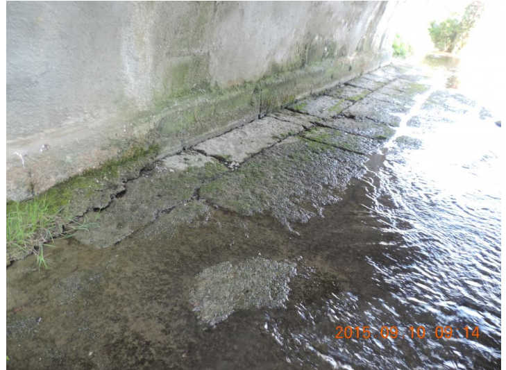
Radier en pierres maçonnées
