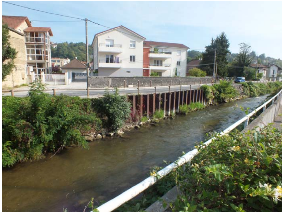
Vue de la berge en rive droite et de la réparation en palplanches
