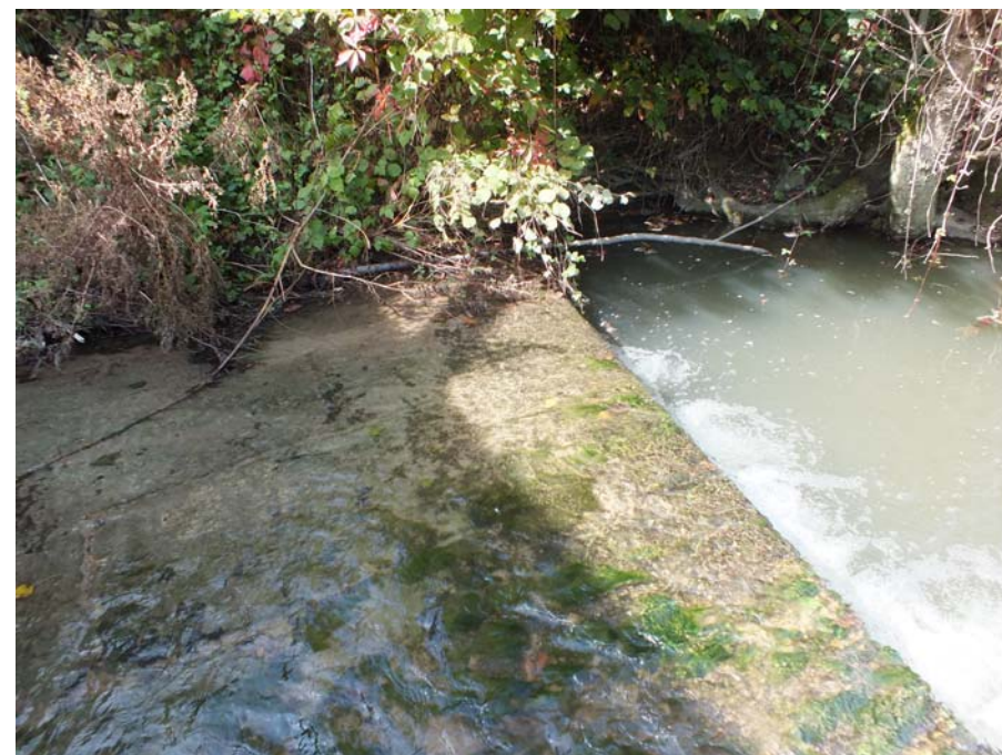
Vue rapprochée du seuil constitué de pierres maçonnées
