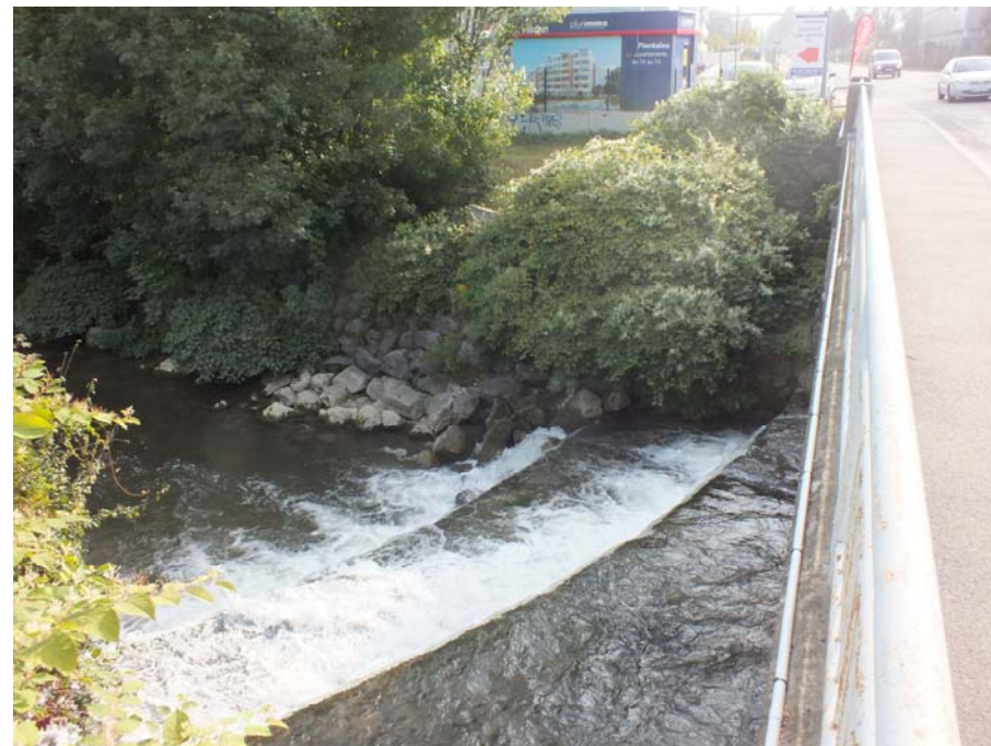
Vue du seuil (RD) depuis le pont
