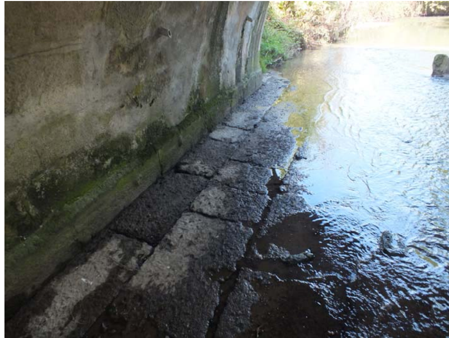
Vue de la structure du radier du seuil
