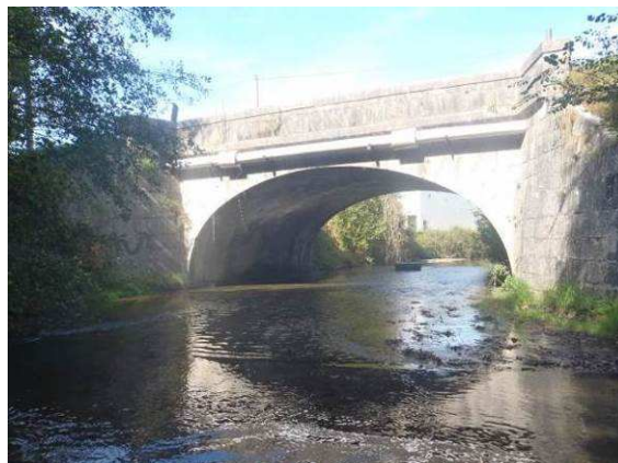
Pont du Gaz – Vue amont
