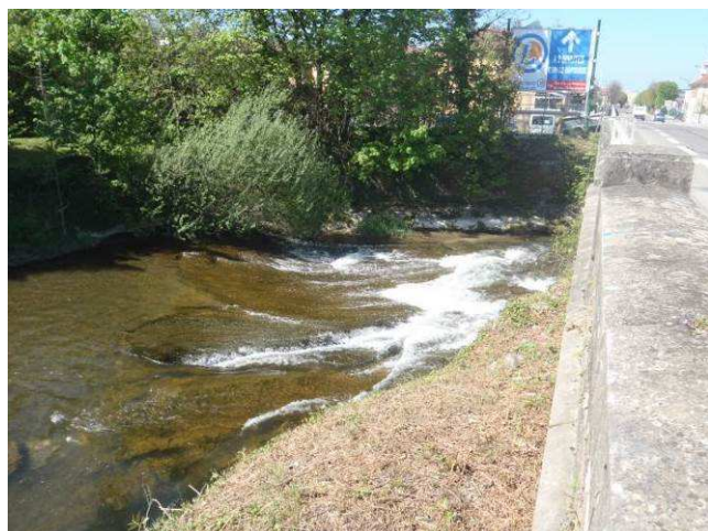
Pont de Ruy – Rampe béton en amont du pont
