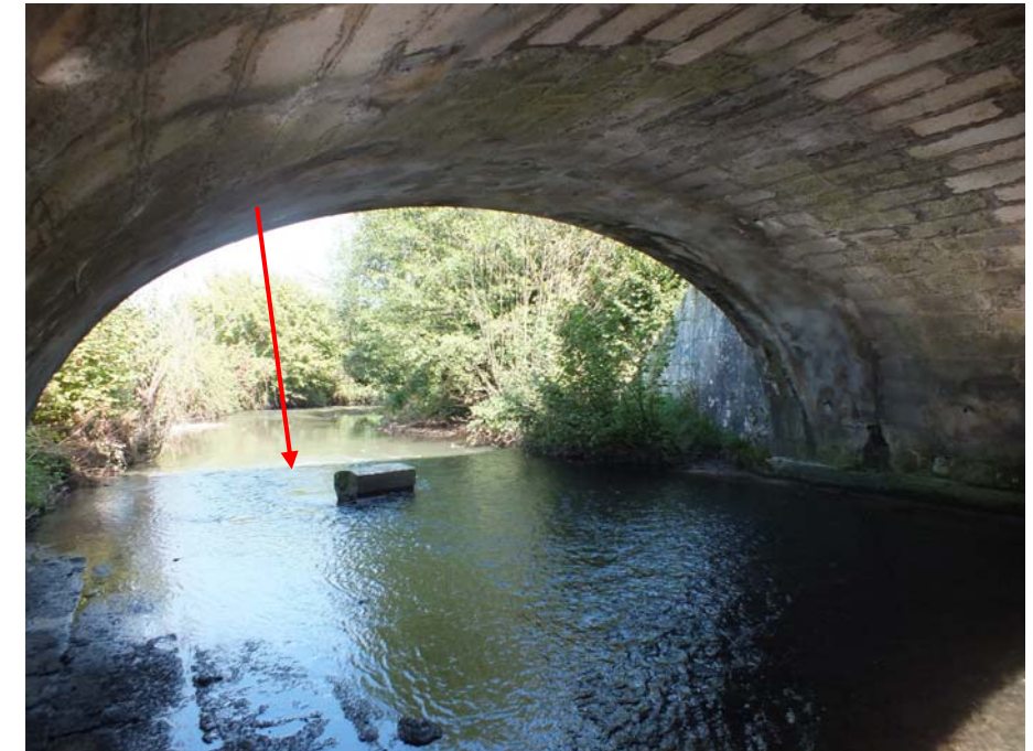
Vue du seuil depuis l'amont et de la voûte du pont
