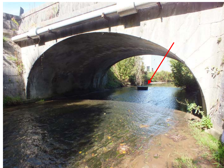
Vue du seuil et du pont depuis l'amont
