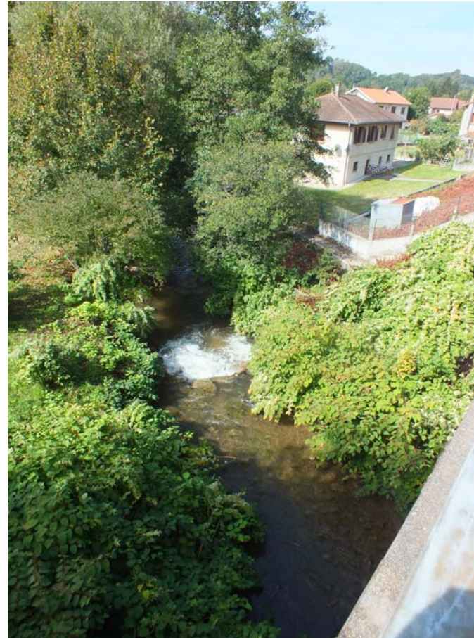
Vue du seuil depuis le pont
