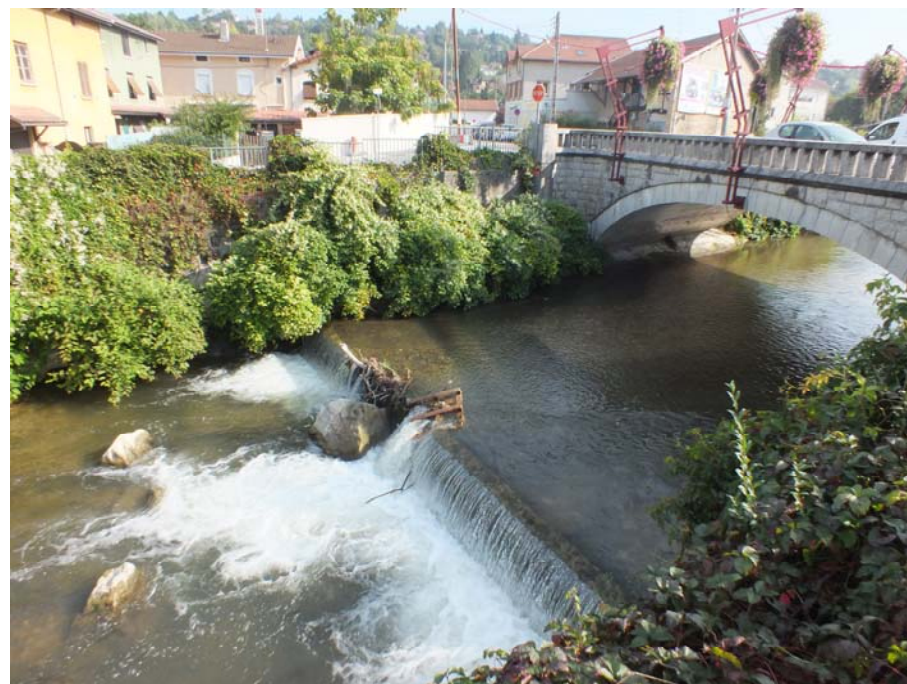
Vue du seuil et du pont depuis l'aval
