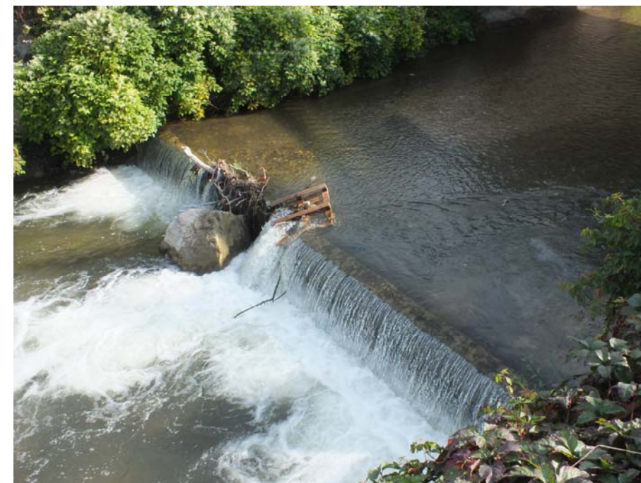
Vue rapprochée du seuil
