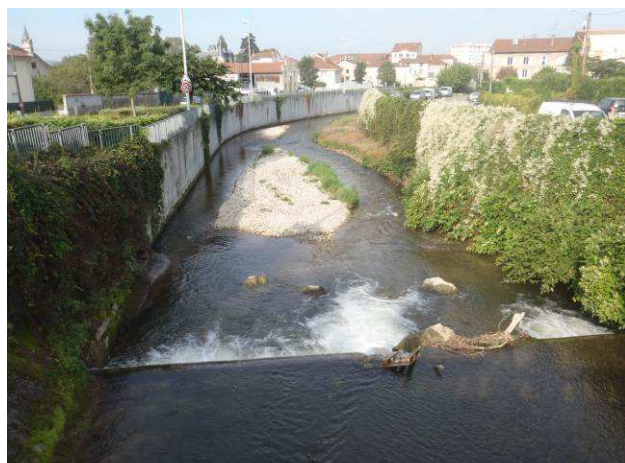
Pont de Ruy – Vue vers l'aval
