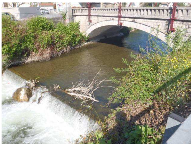
Pont de la Rivoire – Vue vers l'amont
