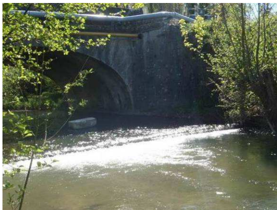
Pont du Gaz – Vue aval
