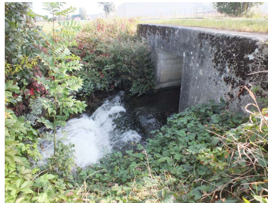
Vue du seuil depuis l'aval
