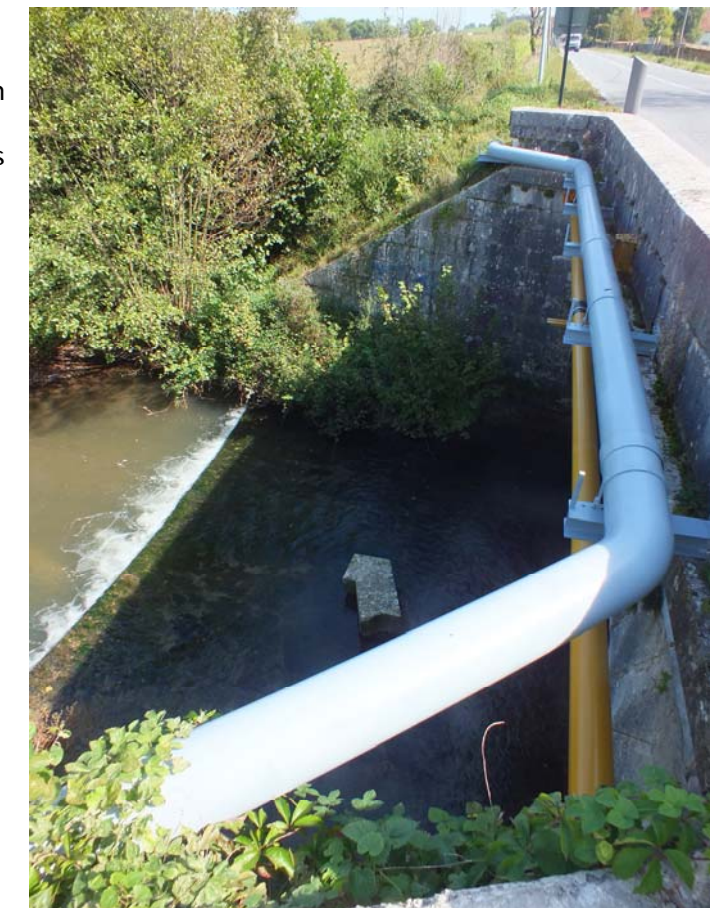
Vue du seuil depuis le pont
