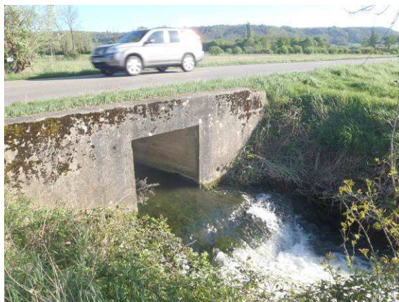
Pont du ruisseau du Ver – Radier béton avec 2 chutes en aval
