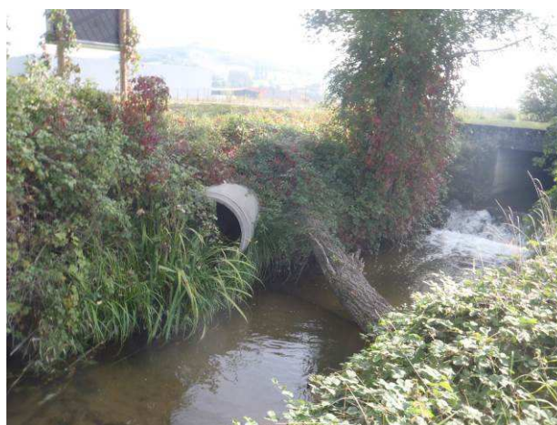
Pont du ruisseau du Ver – Vue de l'aval du radier
