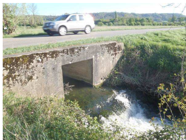
Pont du ruisseau du Ver – Vue de l'aval du radier
