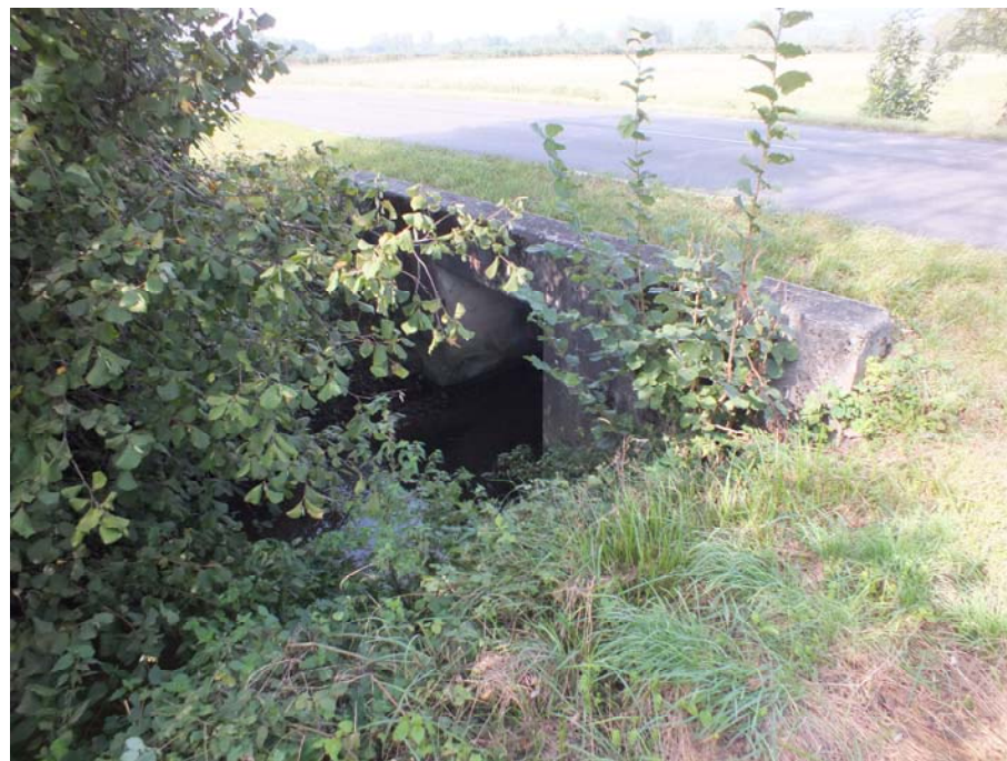
Vue du seuil depuis l'amont
