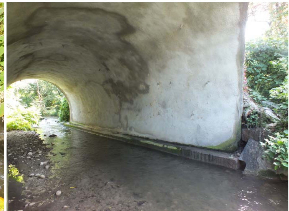
Vue de la voûte du pont et du bloc basculé
