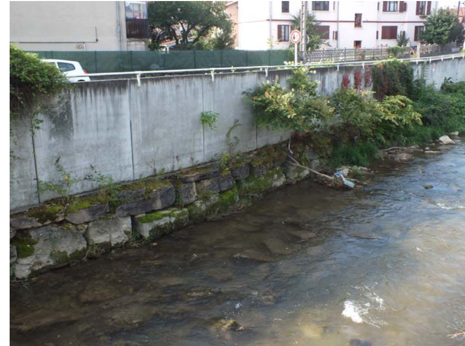
Vue de la berge en rive gauche et du mur béton fondé sur enrochements secs
