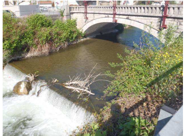
Pont du Curtet – Seuil en enrochements en aval
