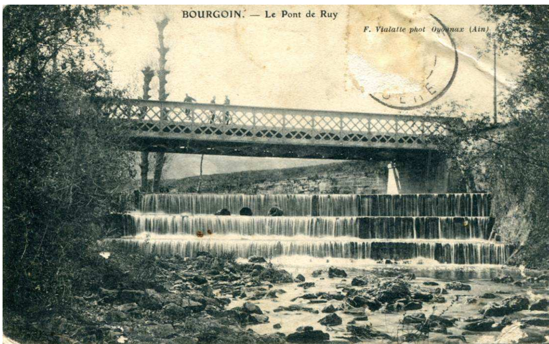
PHOTO 2 : PONT DE RUY AU DÉBUT DU 20 ÈME SIÈCLE
