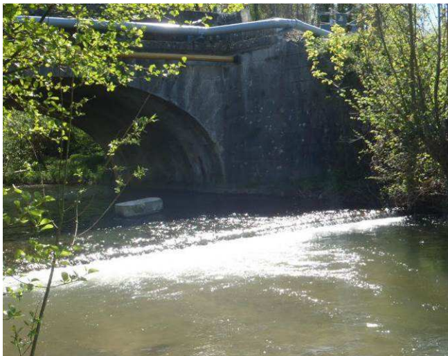
Pont du Gaz – Radier béton avec une chute en aval
