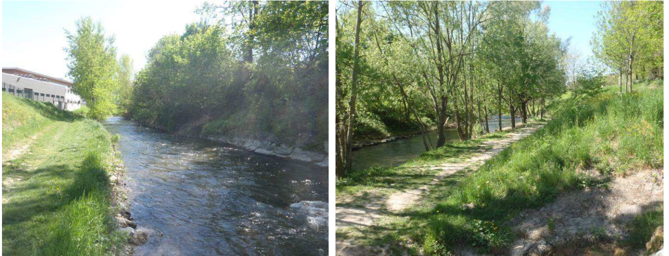
PHOTO 6 : CHEMIN DE PROMENADE EN RIVE DROITE DE LA BOURBRE EN AVAL DU PONT DE RUY
