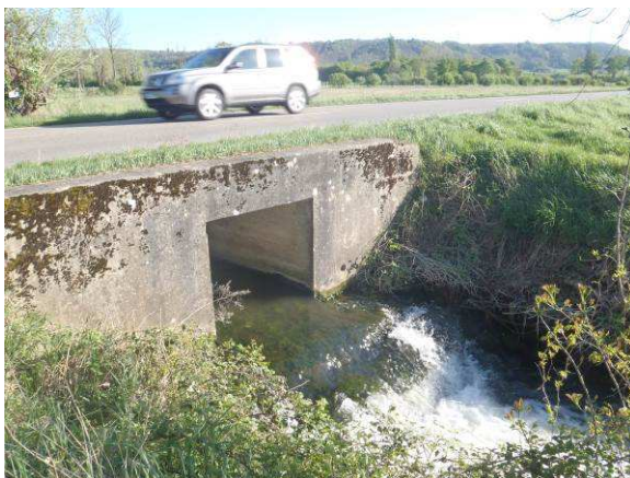
Pont du ruisseau du Ver – Radier béton avec 2 chutes en aval
