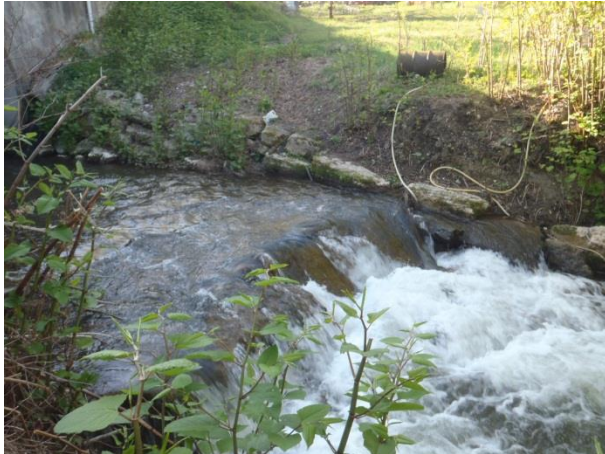
Seuil en blocs d'enrochements
