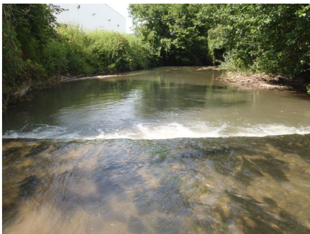
Etalement de la lame d'eau sur le radier
