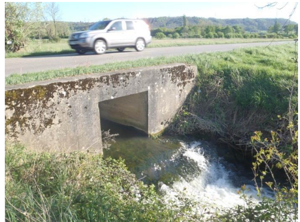
Aval du pont du ruisseau Ver
