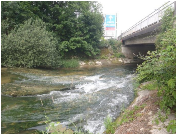
Rampe en béton en amont
