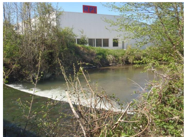
Chute en aval du radier
