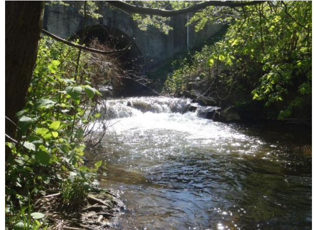
Seuil en blocs d'enrochements
