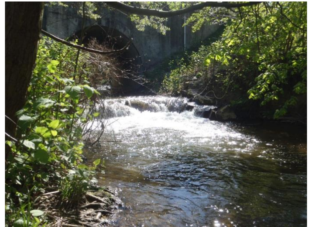
Seuil en blocs d'enrochements
