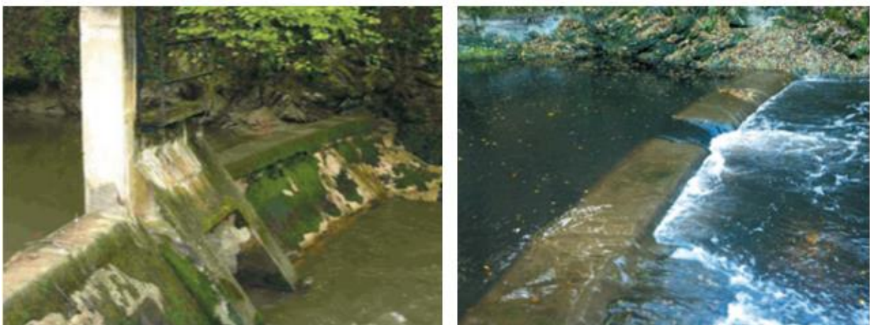
FIGURE 6 : EXEMPLES AVANT/APRÈS D'UN ARUSEMENT PARTIEL (EN BAS)
