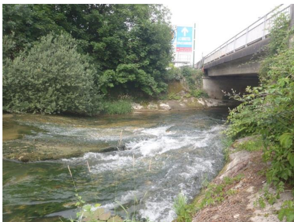
Rampe en béton en amont
