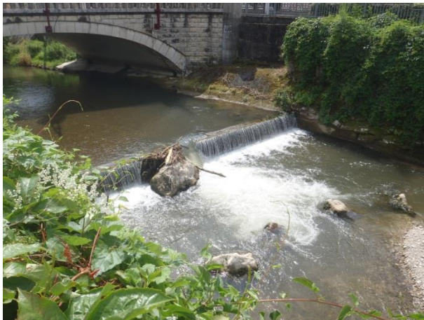
Chute en aval du pont de la Rivoire
