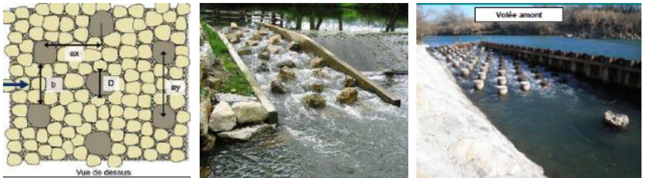
FIGURE 4 : RAMPE EN ENROCHEMENTS EN RANGÉES PÉRIODIQUES
