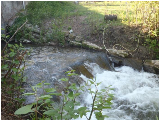
Seuil en blocs d'enrochements
