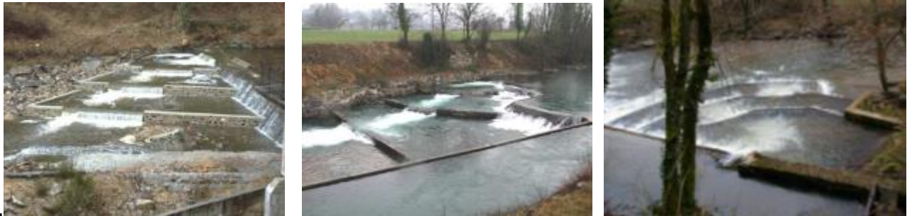
FIGURE 5 : EXEMPLE DE PRÉ-BARRAGES
