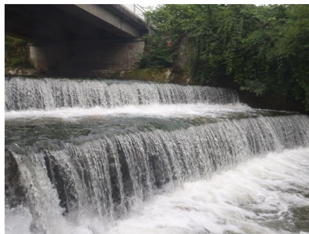
Succession des 2 chutes de 1 m en aval immédiat du pont
