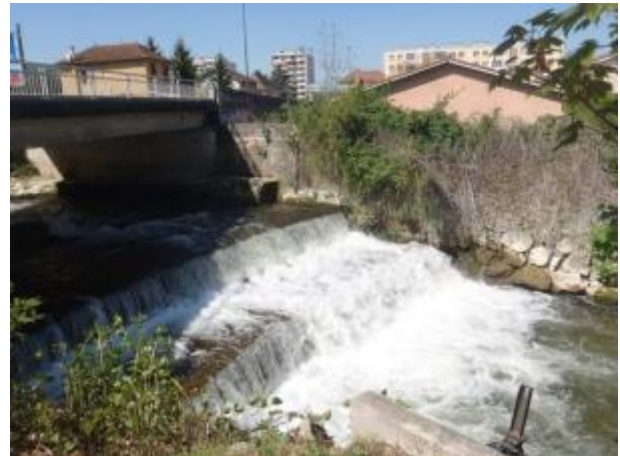
Pont de Ruy – Radier béton avec 2 chutes en aval
