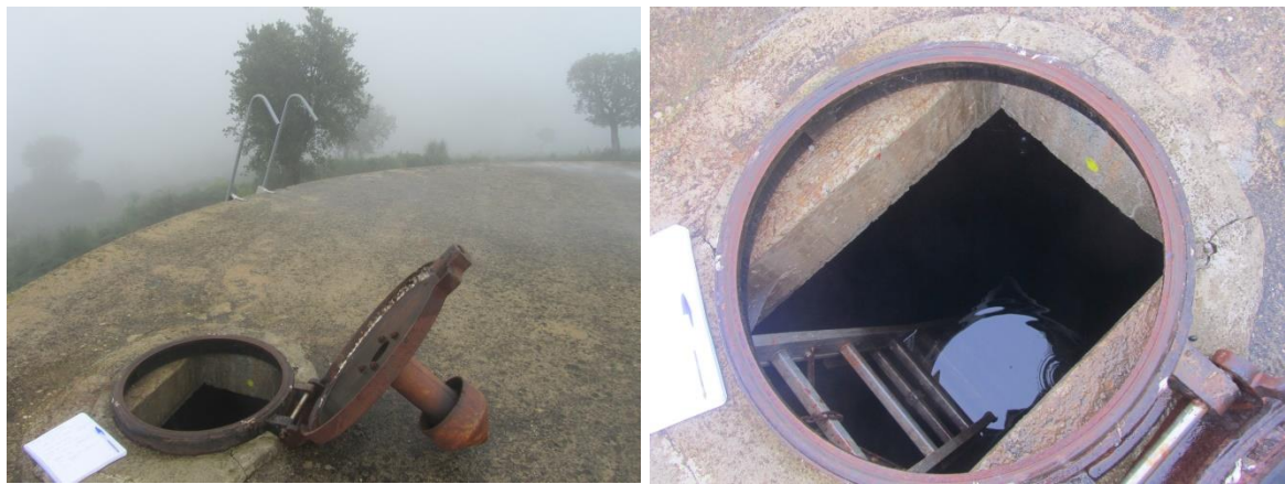
Figure 13 : Dôme extérieur du réservoir
