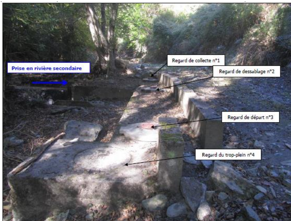
Figure 8 : ensemble des regards de l'ouvrage de dessablage
