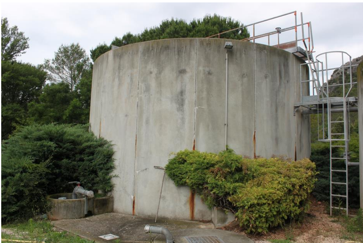
Figure 3: Décanteur digesteur réutilisable comme bassin d'orage
