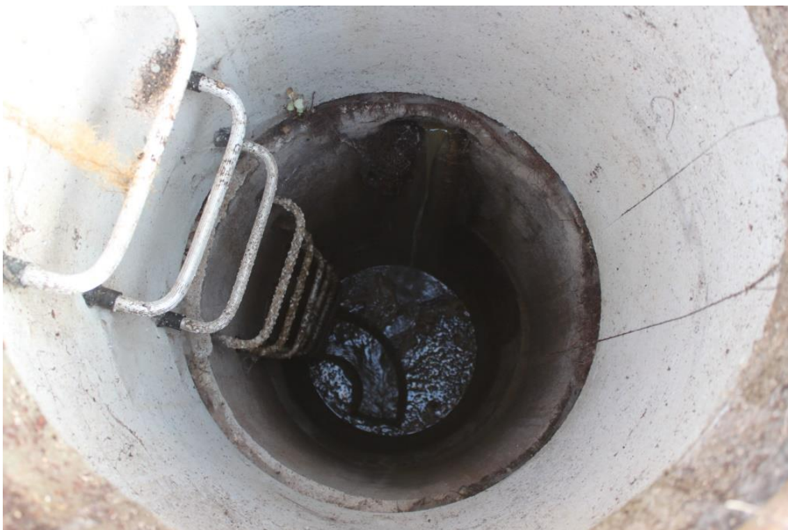
Figure 5; Anneaux de regard non étanche angle RD 24 Lotissement des Lones
