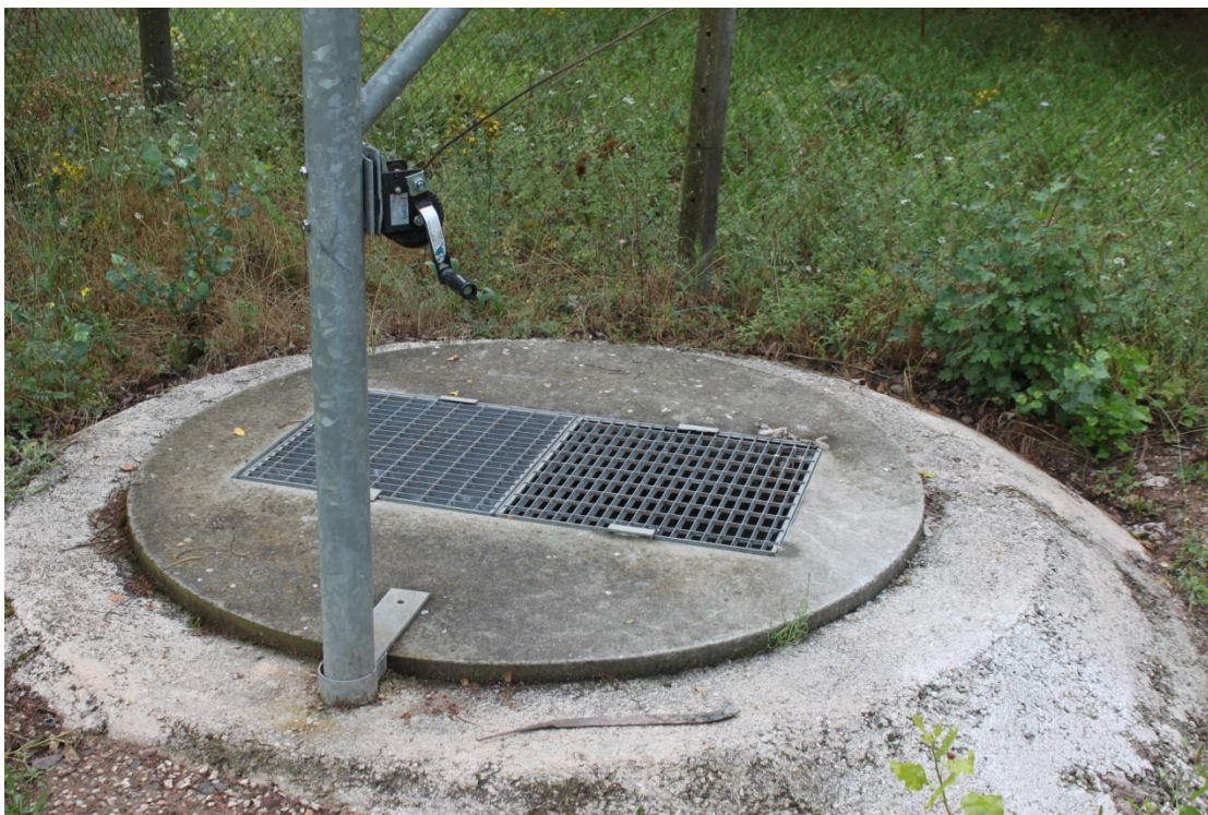
Figure 7: Poste de relevage existant conservé pour les débits by-passés par temps de pluie
