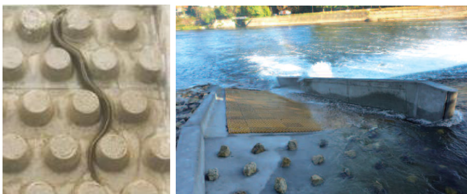
Figure 22 : Exemple d'une anguille progressant entre les plots d'une dalle Evergreen
