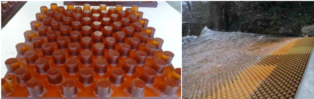
Figure 23 : Dalles à plots élastomériques (source : Marseille Modelage Mécanique)
