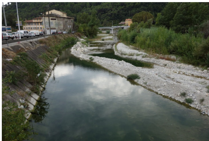
Figure 2 : Obstacle temporaire sur la commune de Drap – septembre 2015 (Source : Fédération Pêche 06)
