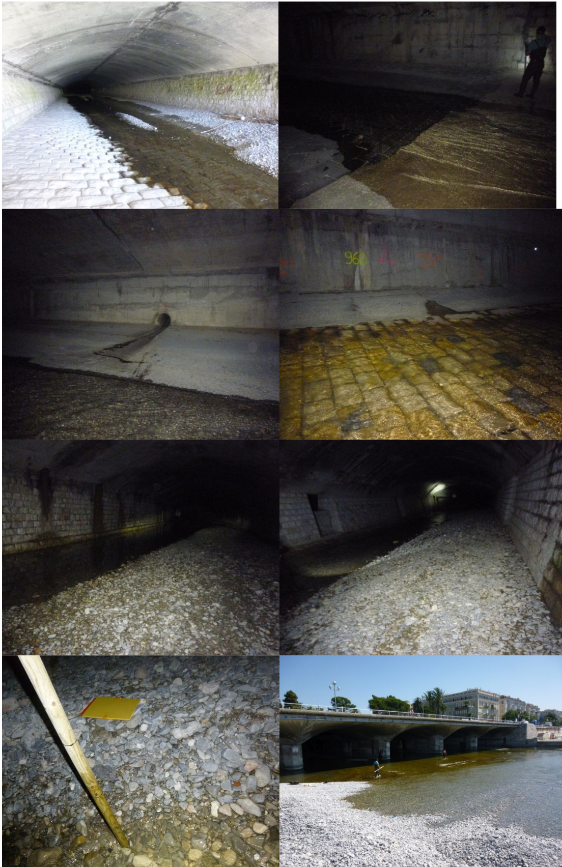
Figure 6 : Photographies de la partie couverte des Paillons
