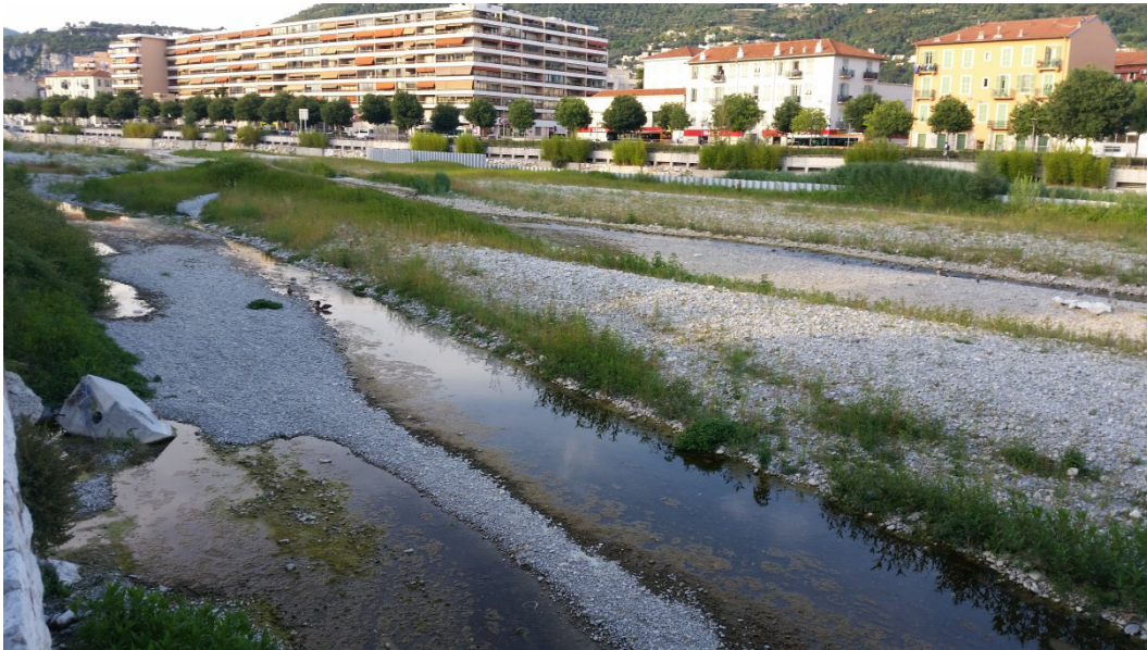
Figure 31 : Lit en amont de la couverture et pénérante couverte en rive gauche - Idealp
