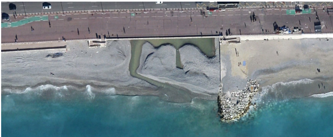
Figure 7 : Vue aérienne de la sortie de la partie couverte des Paillons
