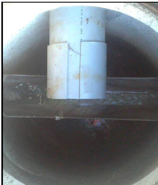
Photographie de l'ouvrage
