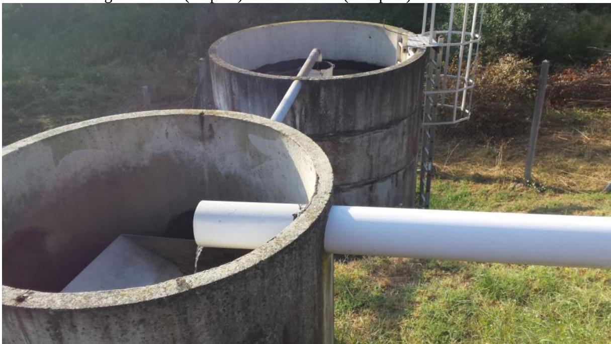
Photo 6 : Ouvrage de bâché (1 er plan) et lit bactérien (2 ème plan)
