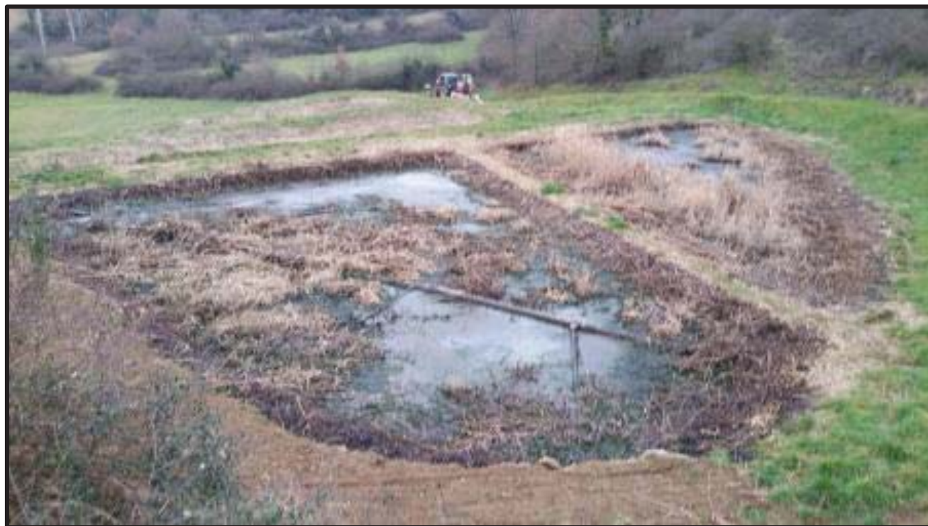
Photo n°2 : Premier étage de filtre
