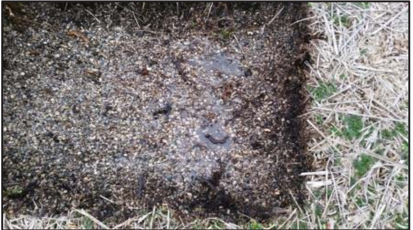
Photo n°12 : Inspection en profondeur du troisième étage de filtre
