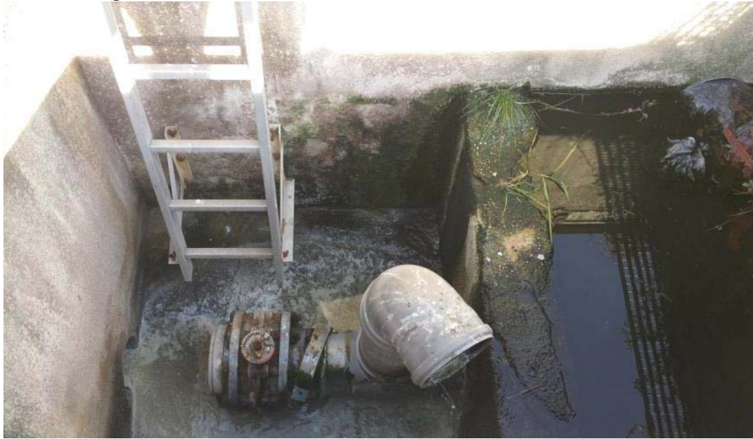
Photo 5 : Répartition des effluents
