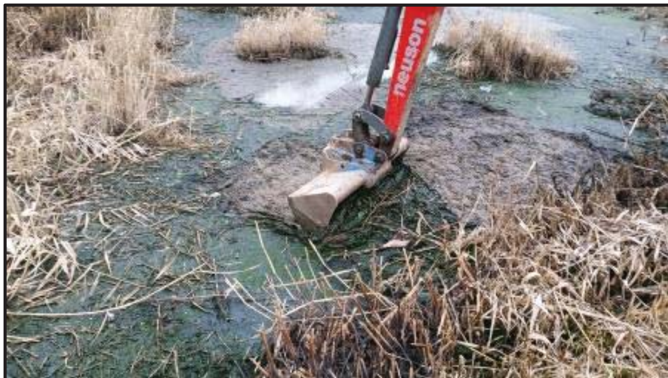
Photo n°3 : Inspection de surface du premier étage de filtre
