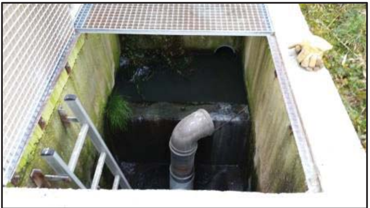
Photo n°13 : Photo du deuxième et troisième ouvrage de génie civil
