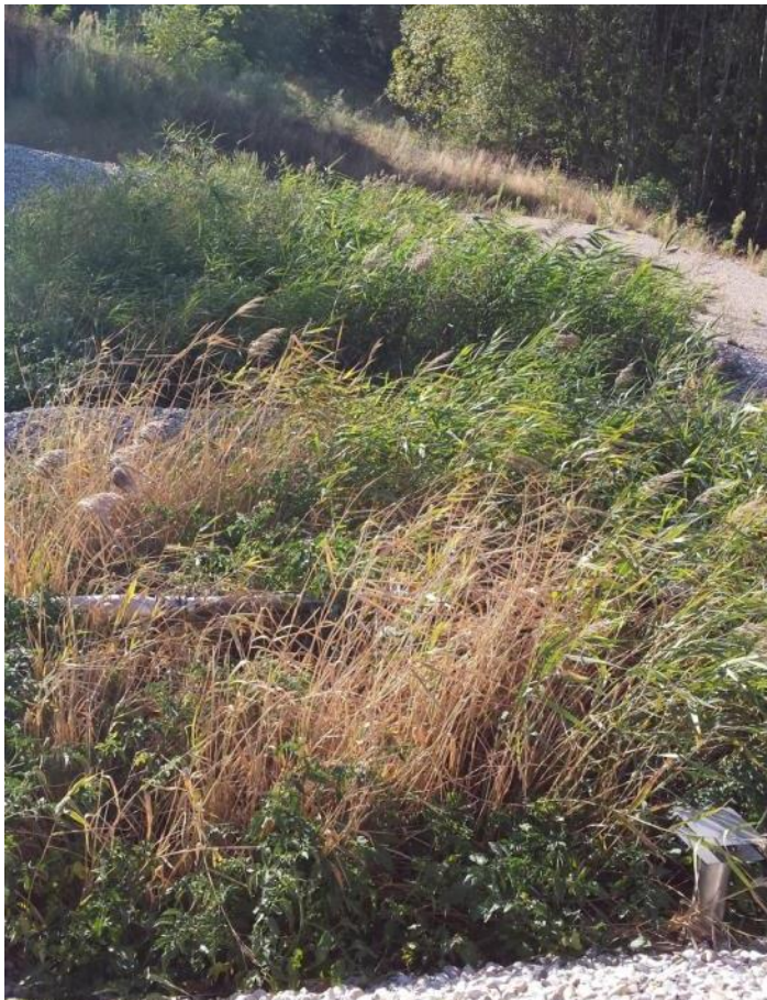
Photo 7 : Premier étage avec trois filtres
