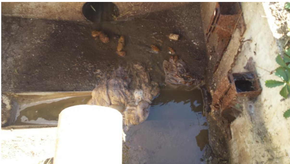
Photo 11 : Déversoir d'orage d'entrée de station
