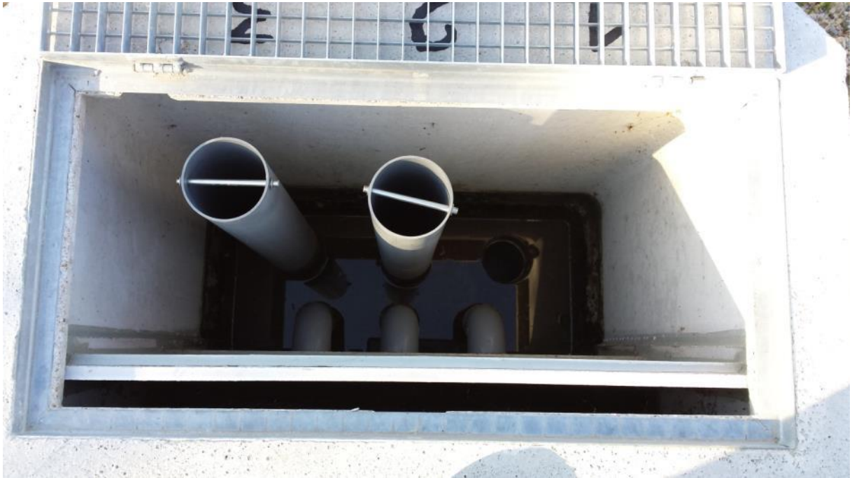
Photo 6 : Ouvrage de bâché
