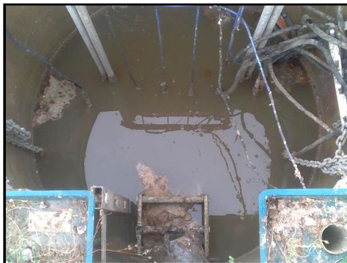
Photo 3 : Vue intérieur du poste de refoulement
