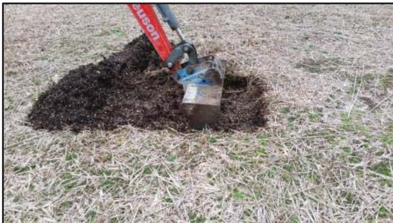
Photo n°11 : Inspection de surface du troisième étage de filtre
