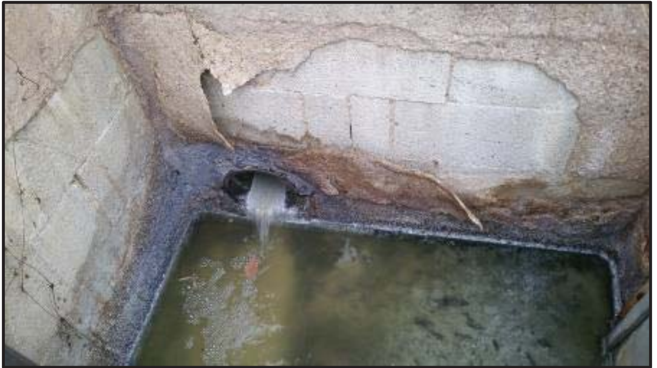
Photo n°5 : Photo du premier ouvrage de génie civil
