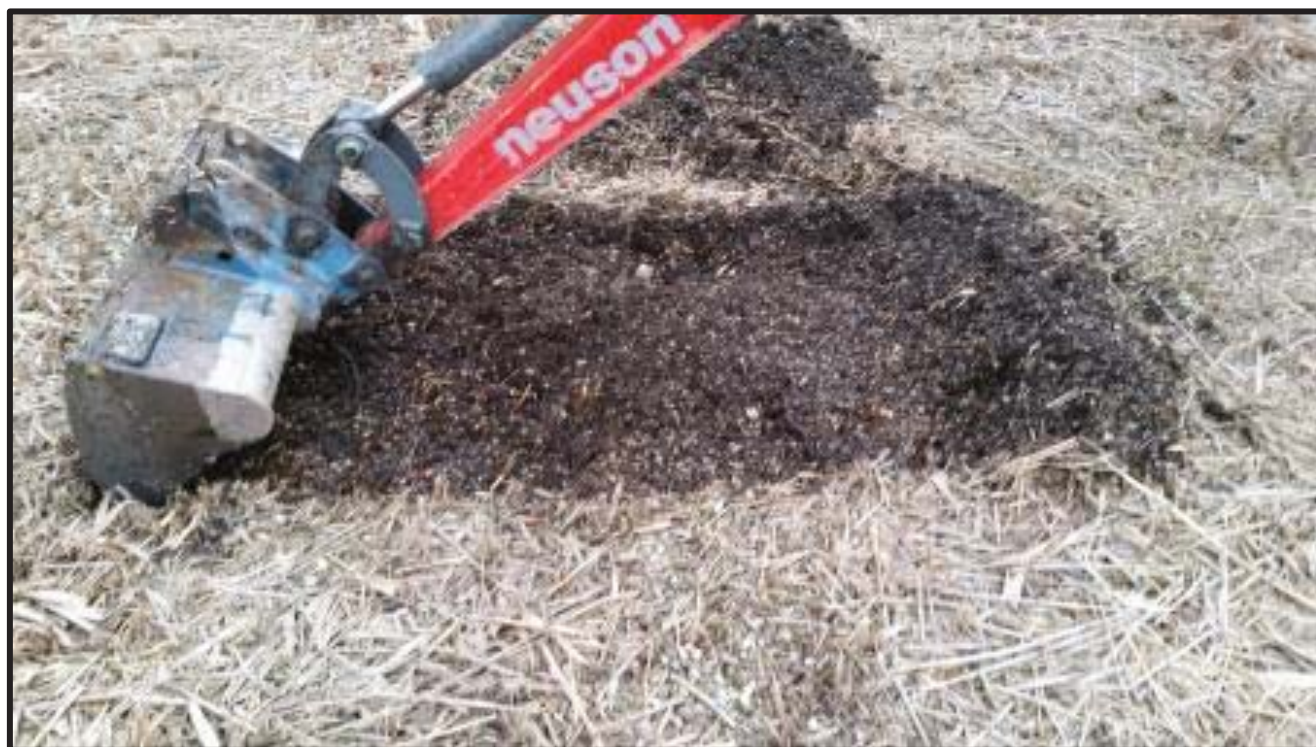
Photo n°7 : Inspection de surface du deuxième étage de filtre
