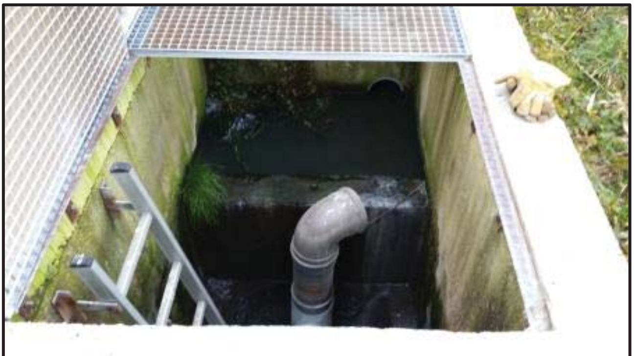
Photo n°13 : Photo du deuxième et troisième ouvrage de génie civil
