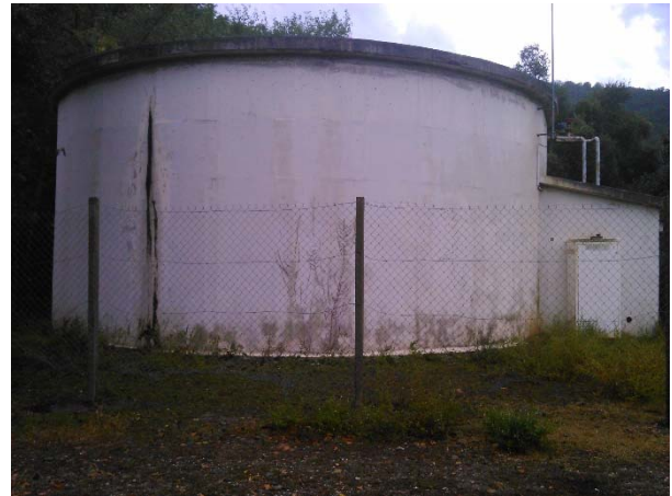
Aperçu du réservoir
