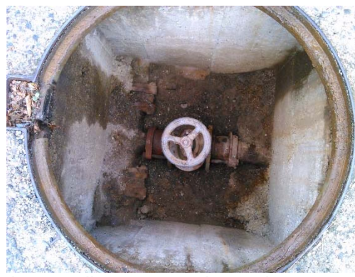
Aperçu d'une vanne de sectionnement
