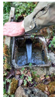
Aperçu du regard de contrôle en aval
