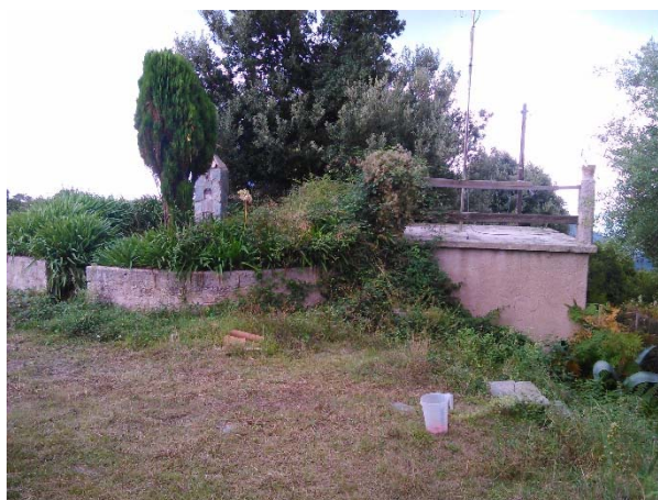
Aperçu du réservoir
