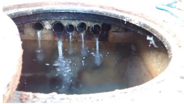
Aperçu de l'intérieur du regard de collecte
