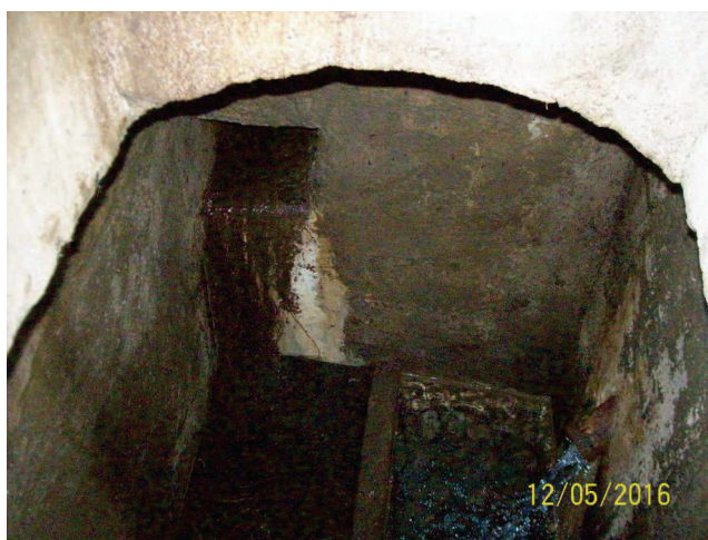
Captage de Caracutu : Venues d'eau et bacs de décantation
