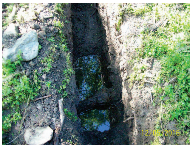
Canalisation d'adduction entre les sites de Piovale et de Caracutu
