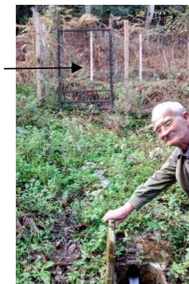
Vue générale du captage de MONTICELLO
