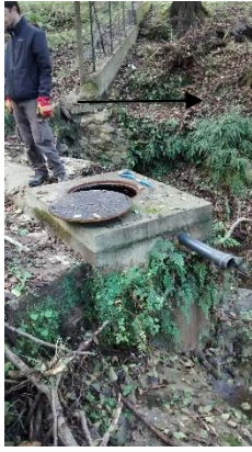
Vue du regard de collecte
