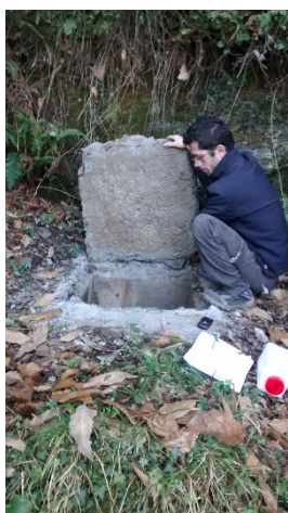
Aperçu de la dalle de captage
