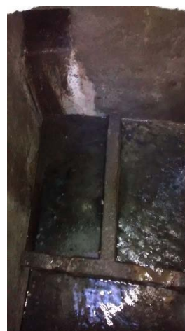
Aperçu de l'intérieur du regard de collecte
