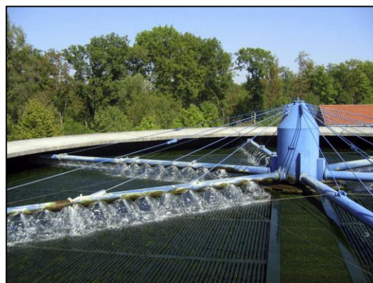
FIGURE 23 : PRINCIPE DE FONCTIONNEMENT DU LIT BACTERIEN (SOURCE : GUNT HAMBURG)
