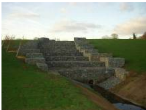
Déversoir en gradins (gabions)
