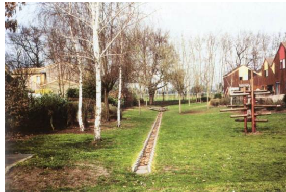
Noue en béton Bruges (33)
