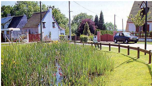
Fossé de rétention
