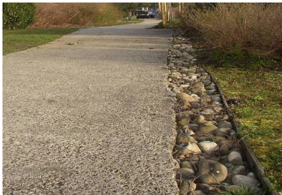
Petite tranchée drainante le long d'un espace piétonnier
