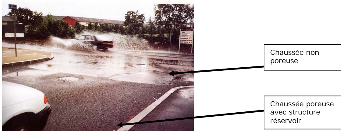
Chaussée à structure réservoir, Craponne (CERTU - 1994)
