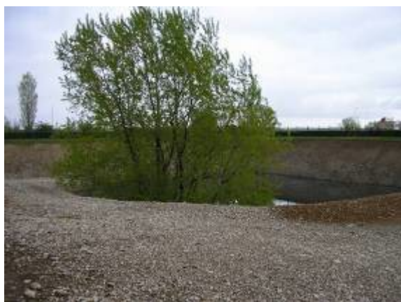
Bassin d'infiltration après une pluie
