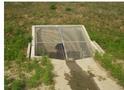
Grille de protection sur ouvrage de sortie
