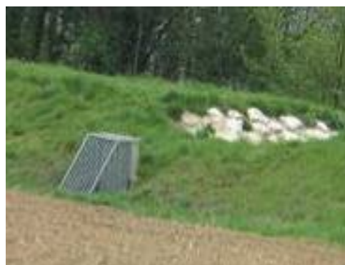
Déversoir en enrochements bétonnés sur bassin agricole
