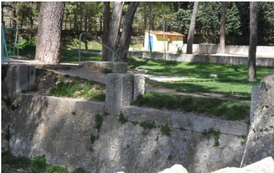
Figure 14 : déversoir digue intermédiaire - Vallon Ste Madeleine
