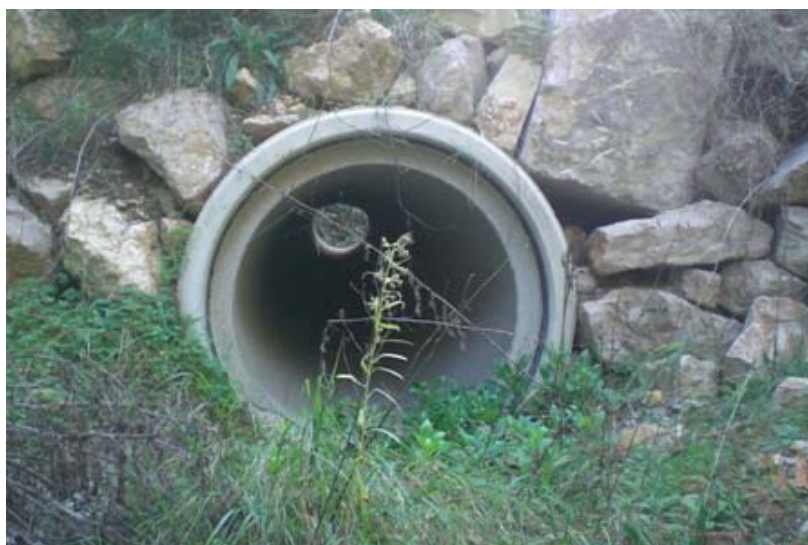
Figure 15 : Passage sous chemin d'accès - Vallon de Ste Madeleine
