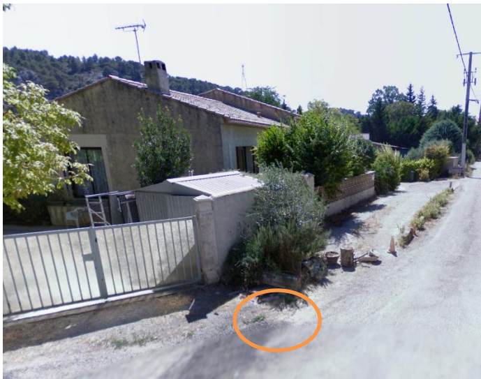
Fig. 8. VUE DE LA ROUTE DE SIÈGE ET DU RÉSEAU DE COLLECTE
