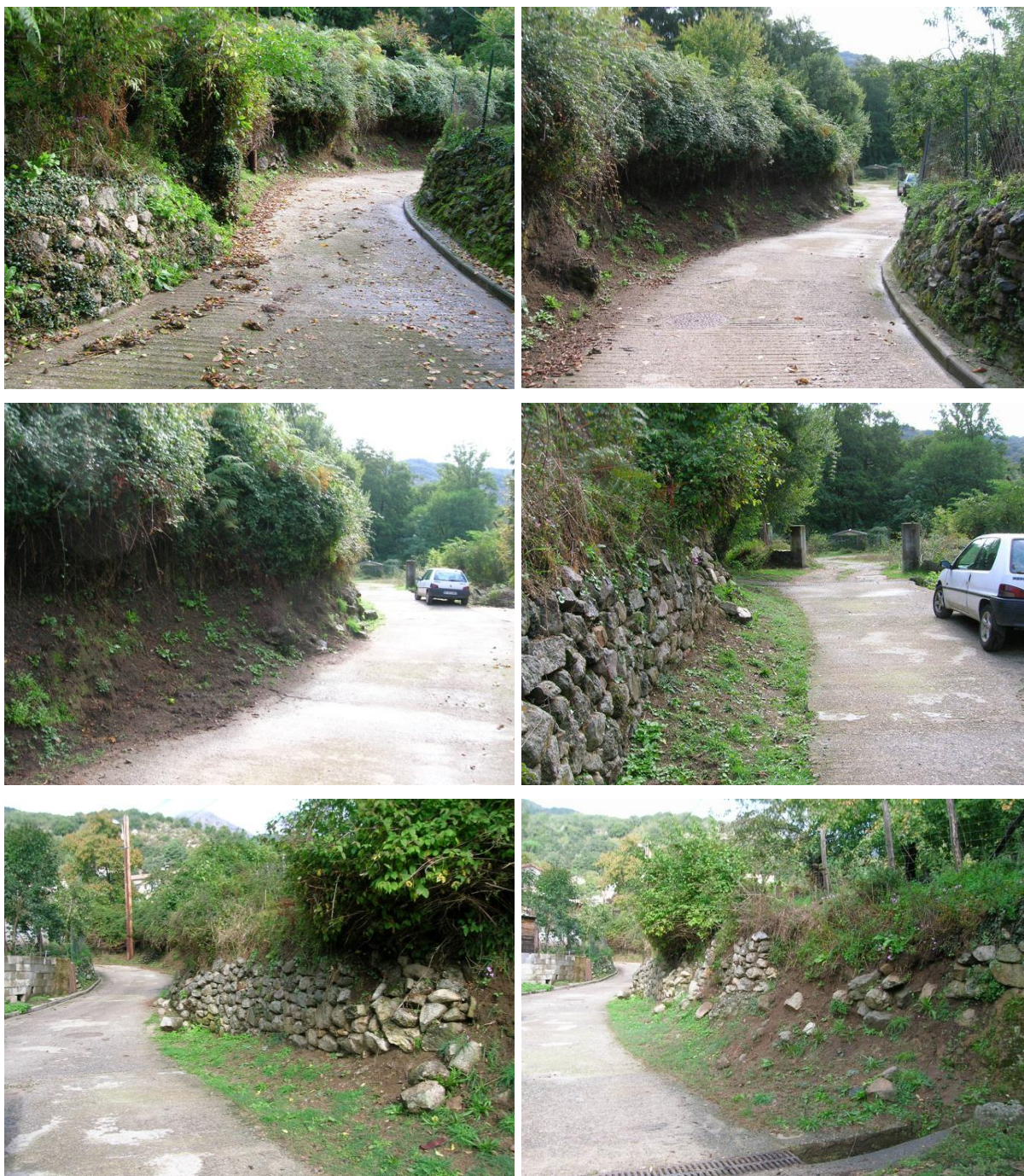
Figure 30 : Route d'accès à la station
