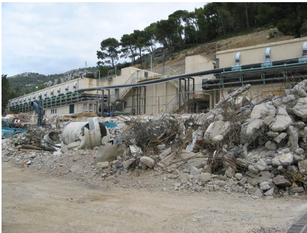
Figure 13 : Usine de la Valette en travaux (photo SCE 2009)
