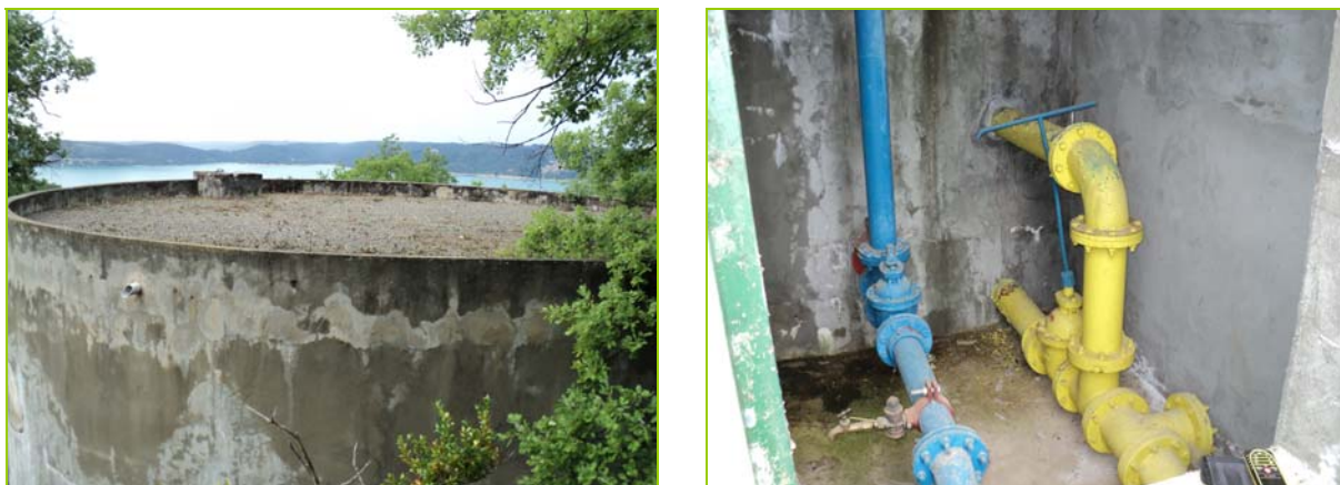
Figure 7 : Ancien réservoir de Bauduen et sa chambre de vannes
