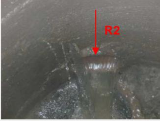
Entrée d'eaux par fissure au-dessus de l'arrivée d'eaux usées |                                                                                     | Beaucoup d'eaux claires<br>Traces de mise en charge dans regard<br><br>Heure 16/01/14 : 8h25                                                                                                                               | Beaucoup d'eaux claires<br>Traces de mise en charge dans regard<br><br>Heure 22/01/14 : 8h20        |
