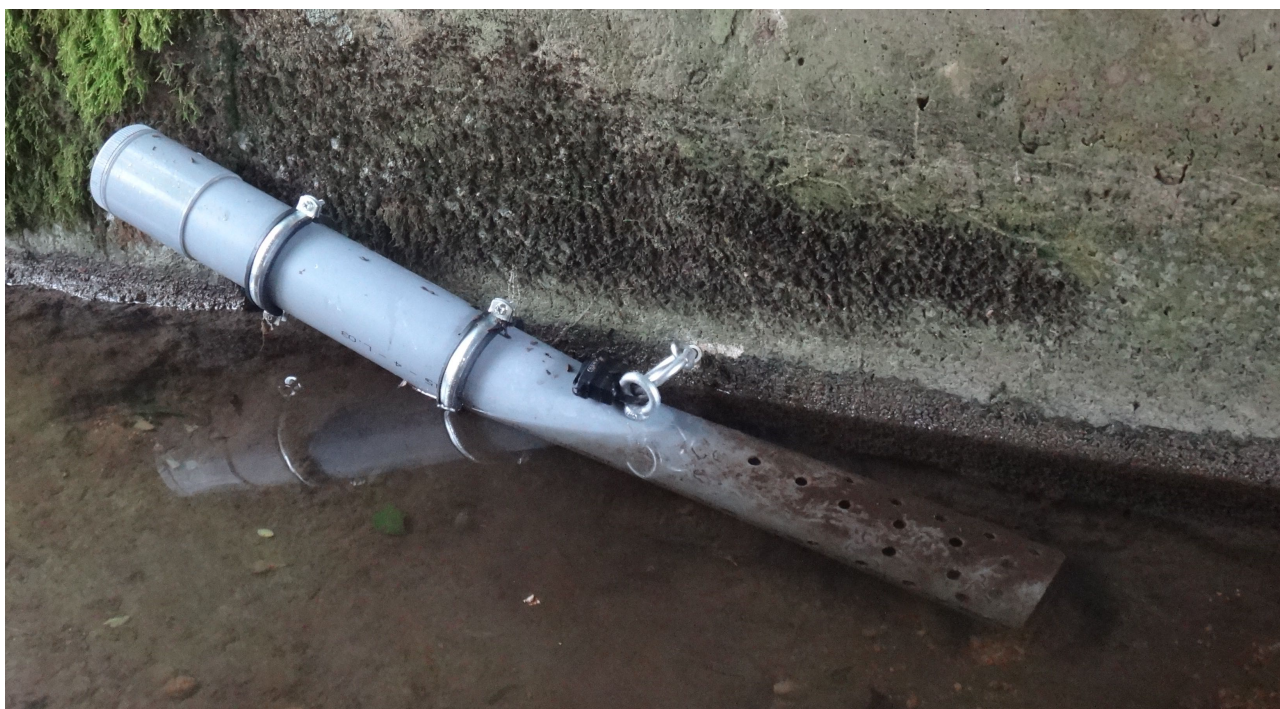
Figure 15. Dispositif de fixation et de protection de la sonde conductivité turbidité implantée dans la partie aval du Ruisseau de Remoray (sous le pont du chemin agricole menant au Crossat).
