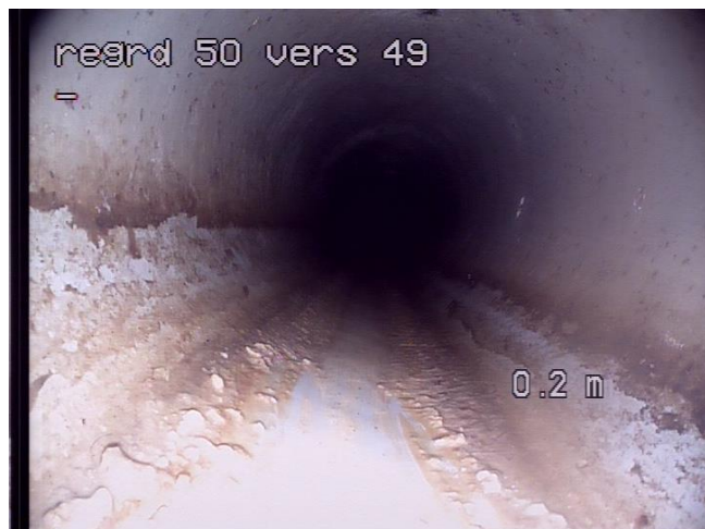
n°1 Démarrage de l'inspection
