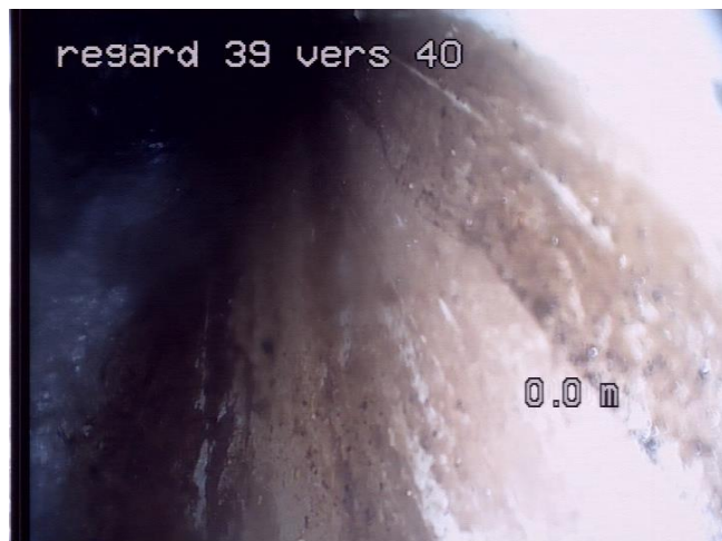
n°1 Démarrage de l'inspection
