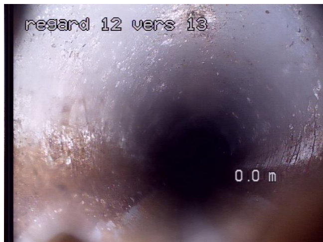
n°1 Démarrage de l'inspection
