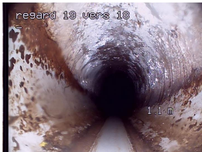
n°1 Démarrage de l'inspection
