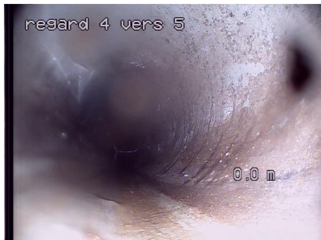
n°1 Démarrage de l'inspection
