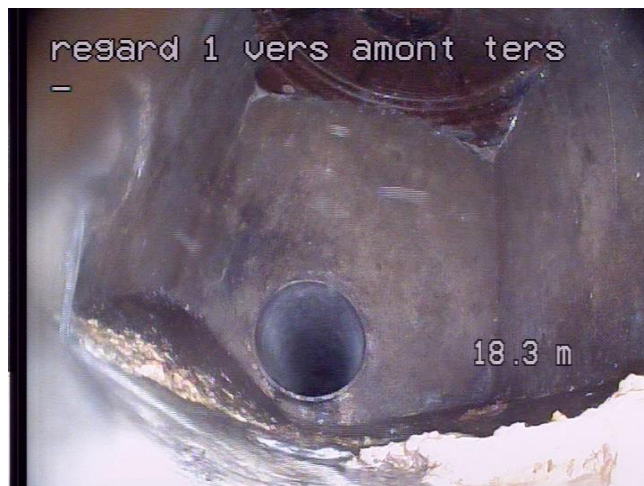
n°2 Arrivée dans R0 enterré
