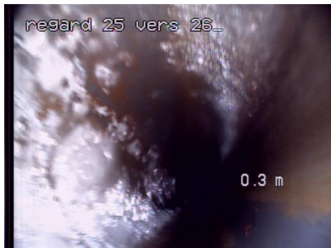
n°1 Démarrage de l'inspection
