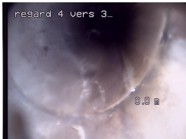
n°1 Démarrage de l'inspection
