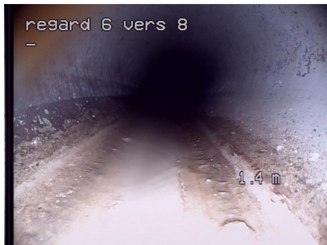
n°1 Démarrage de l'inspection
