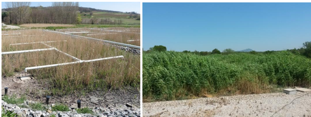
Figure 3: Station de Chantemerle les Blés (26) (gauche) et Station de Viols le Fort (34) (droite) – Réalisations du Groupe « Syntea/Epur Nature/Eco Bird » (sources respectives : SATESE 26/07 et Irstea)
