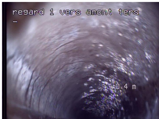
n°1 Démarrage de l'inspection
