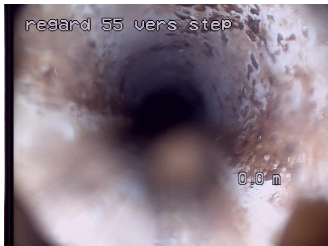
n°1 Démarrage de l'inspection
