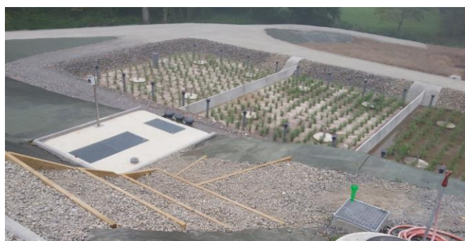
Figure 5 : Station de Chiré en Montreuil (86) – Réalisation E.R.S.E (source : E.R.S.E)
