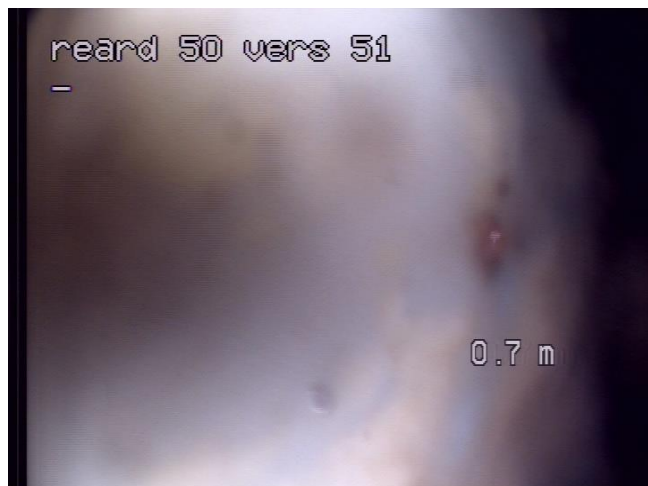
n°1 Démarrage de l'inspection
