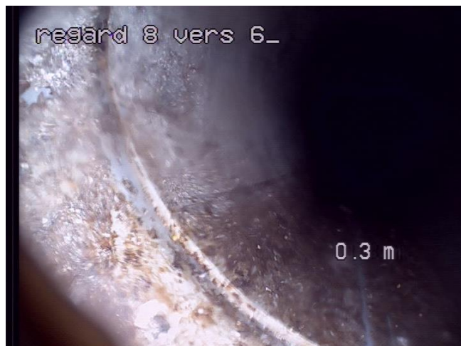
n°1 Démarrage de l'inspection
