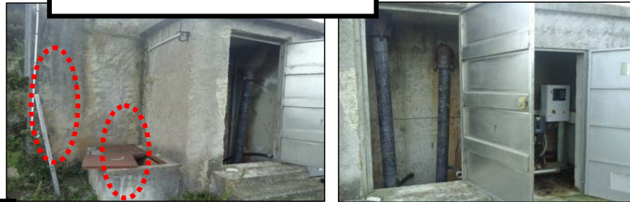
Accès chambre de vannes
