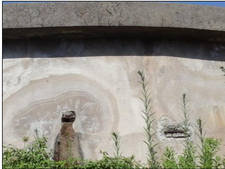
Figure 13 : Vue de l'état du génie civil du réservoir SAB
