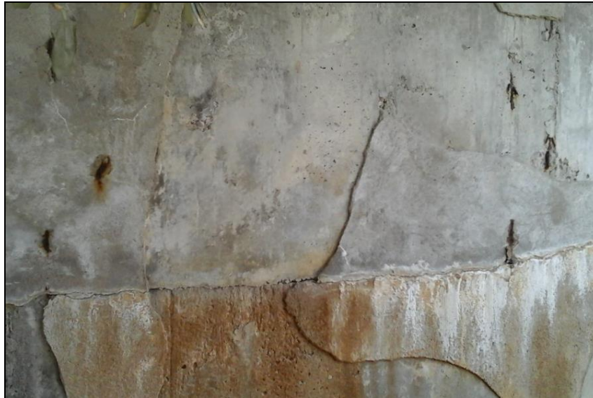
Figure 14 : Vue de l'état du génie civil du réservoir GENDARMERIE
