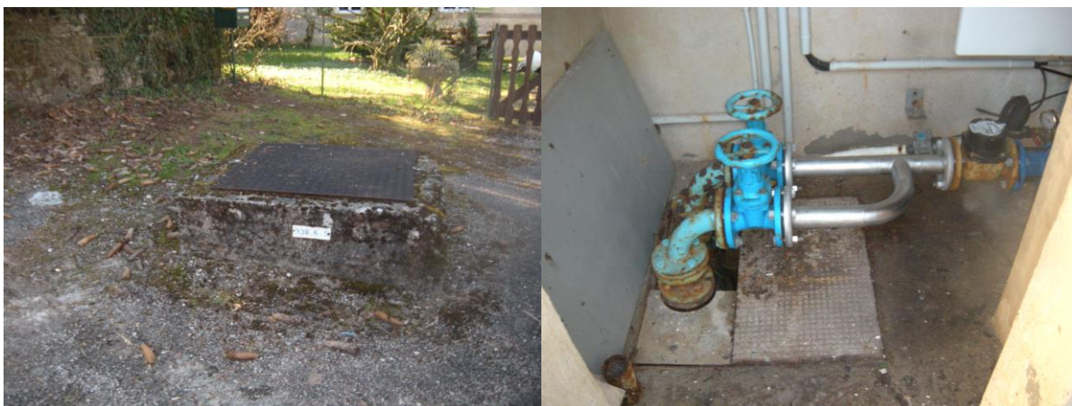
Fig. 6. Chambre de captage et station de pompage
