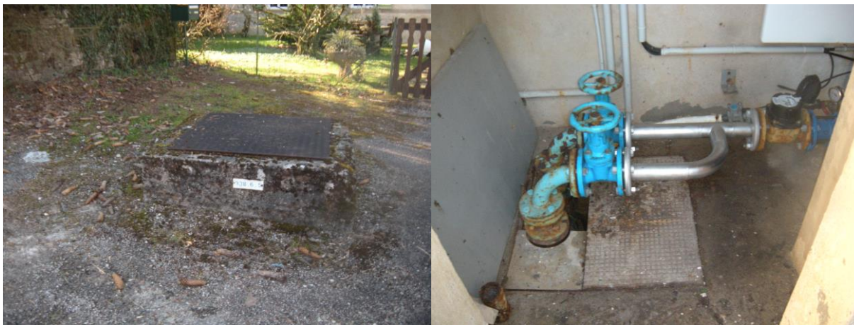
Fig. 9. Chambre de captage et station de pompage
