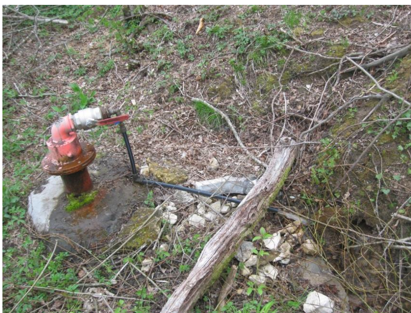
Figure 9 : Photographie du forage du Moulin de la Cude
