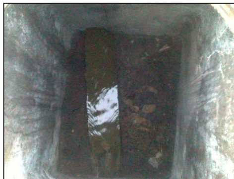
Pas de maillage et DN 200 et non DN 400 mm
