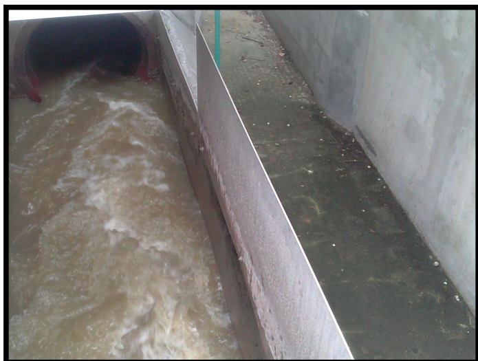
Intérieur du Déversoir
