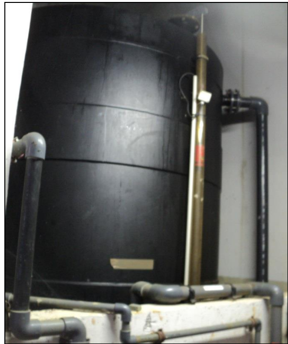
Figure 22 : Vues de la pompe doseuse et de la cuve de stockage de chlorure ferrique
