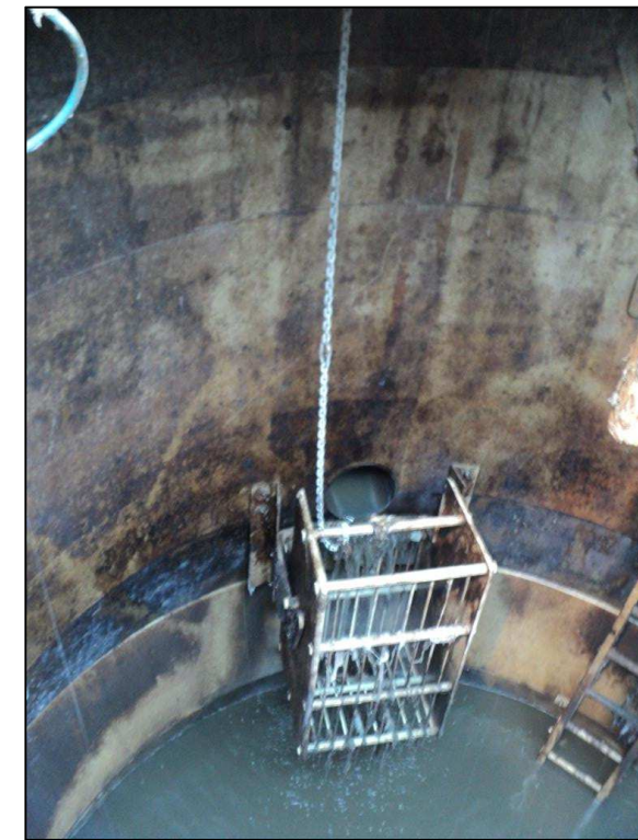
Arrivée eaux usées et sonde de niveau
