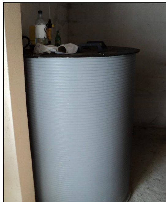
Balon anti-bélier et armoire électrique et Cuve stockage nutriox avec pompe doseuse
