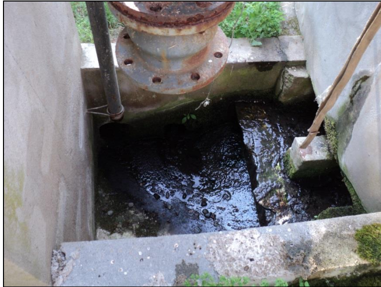
Figure 14 : Vue de l'ouvrage de rejet en sortie de traitement
