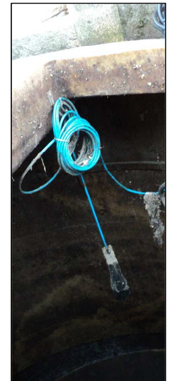
Arrivée eaux usées et sonde de niveau
