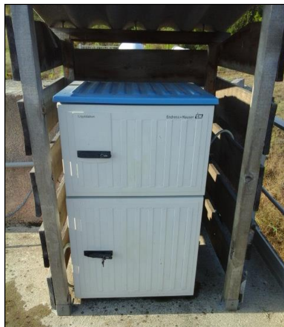
Figure 29 : vue des préleveurs automatiques en entrée et sortie de traitement
