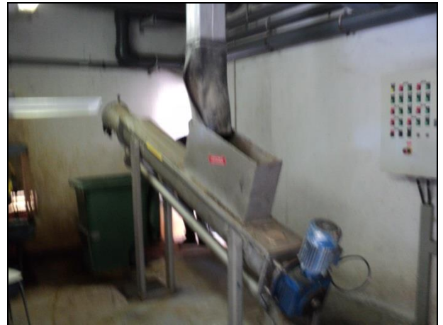
Figure 20 : Vues de l'ouvrage de dégrillage et de la vis de convoyage compactage
