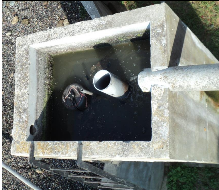
Figure 12 : Vue de l'ouvrage de chasse
