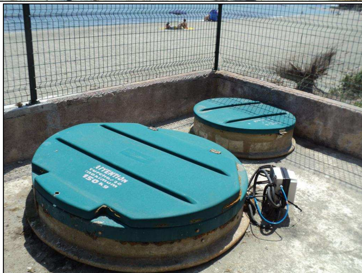
Balon anti-bélier et armoire électrique et Cuve stockage nutriox avec pompe doseuse
