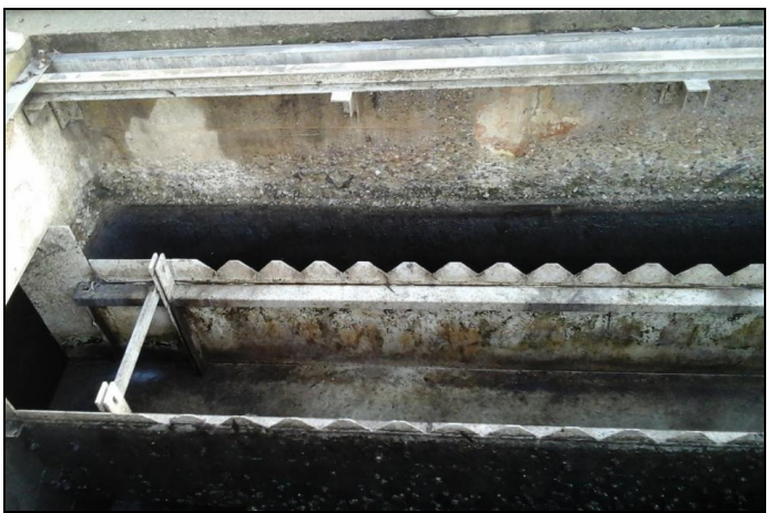
Figure 39 : Vues des sondes de mesures en continue et d'un des décanteur lamellaire
