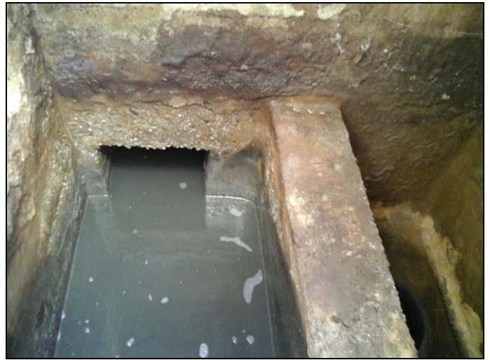
Figure 38 : Vues du canal entre le dessableur/dégraisseur et les bassins d'aération
