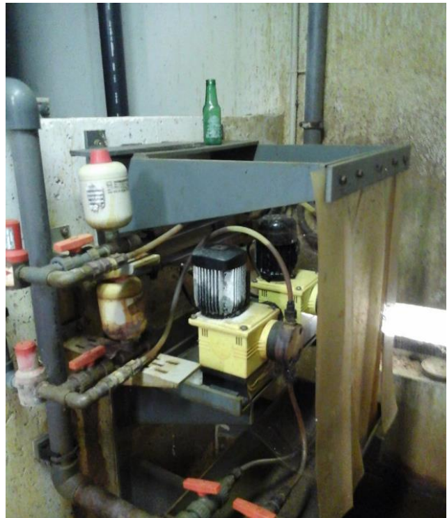
Figure 41 : Vues du silo à chaux et des pompes doseuses de chlorure ferrique
