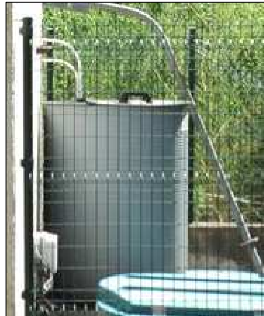
Cuve stockage nutriox
