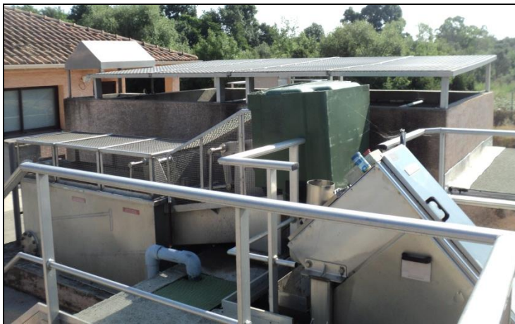
Figure 20 : Vues de l'ouvrage de dégrillage et de la vis de convoyage compactage
