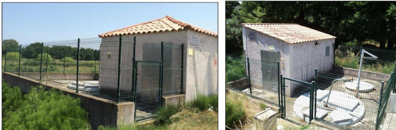
Figure 71 : Vues des PR pont de Bravone et Alzicciola situés en zone inondable
