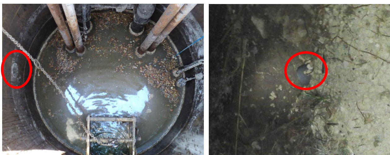
Figure 59 : Vues des trop-pleins des PR de Bagherra, de Marines Sud et d'Alzicciola
