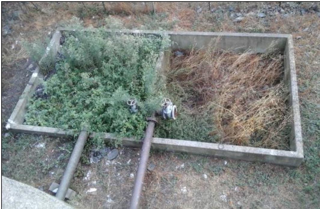
Figure 15 : Vue des lits de séchage
