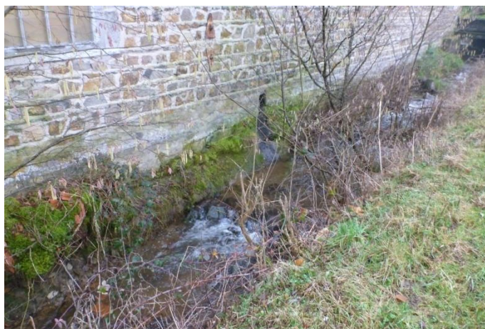
Figure 19 : photographie du mur de l'habitation le long de la Provenchère.
