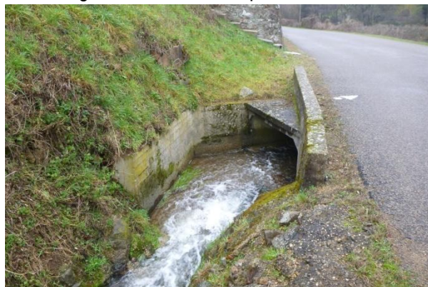
Figure 7 : vue depuis l'amont du cadre béton avec entonnement
