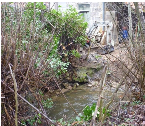
Figure 15 : Photographie des rejets le long de l'habitation
