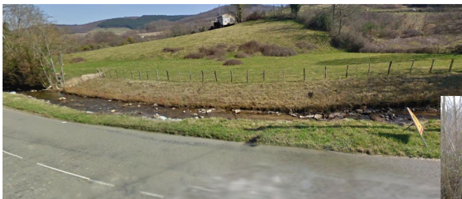
Figure 8 : secteur conforté après démolition de l'ouvrage (mars 2009 - source Google map)
